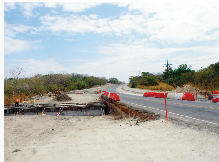
Construcción de alcantarillas de cuadro
