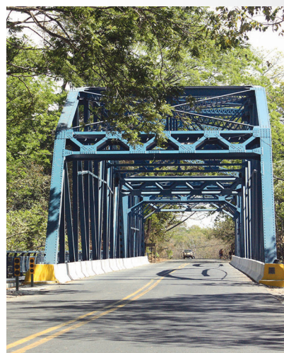
Puente sobre el río Abangares
