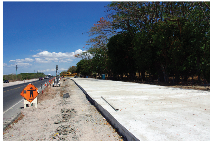
Colocación de paños de concreto
