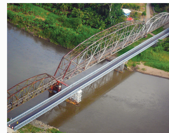
Estructura armable sobre el río Sixaola (puente binacional)
