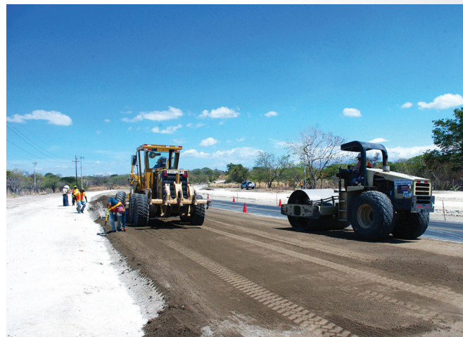
Colocación de préstamo seleccionado (material de relleno)
