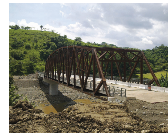
Puente sobre el río Grande de Tárcoles
