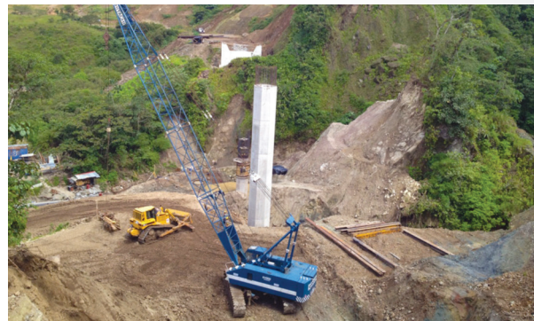
Construcción Puente Laguna
