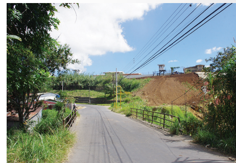
Puente Fusilera, sobre Río Cañas, Desamparados
