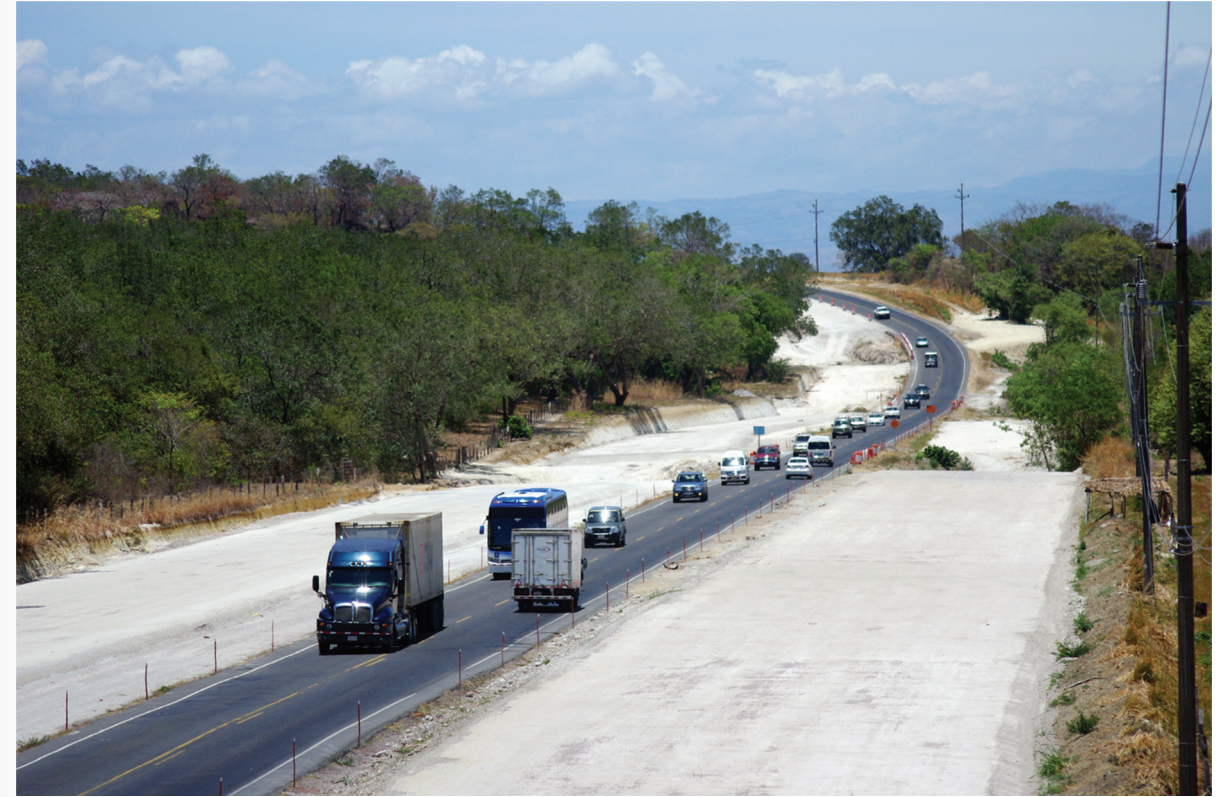
Colocación de sub-base
