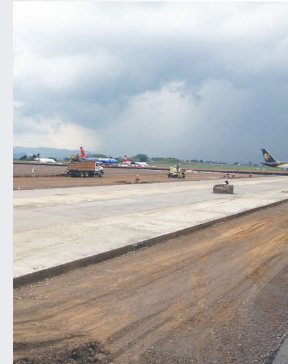
Construcción de la plataforma remota, Aeropuerto Juan Santamaría
