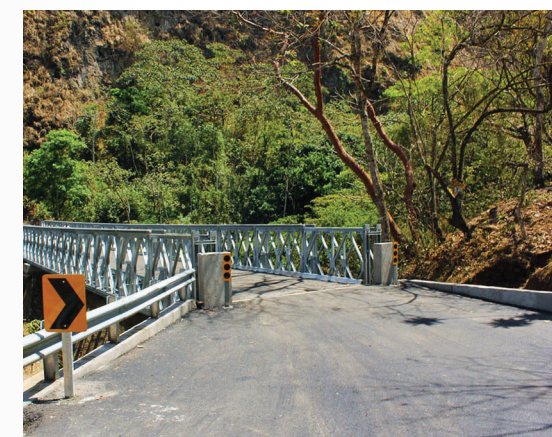
Puente armable ubicado en Santa Eulalia
