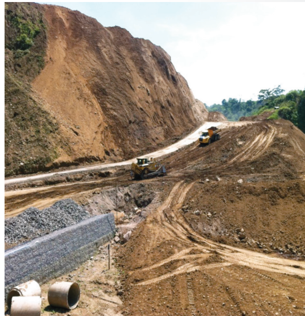
Obras de construcción de la carretera a 4 carriles
