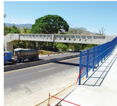
Puente peatonal ubicado en la comunidad de Balsa, Atenas
