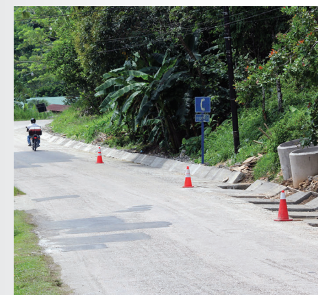
Construcción de cunetas, Neily-Fila de Cal, RN 237
