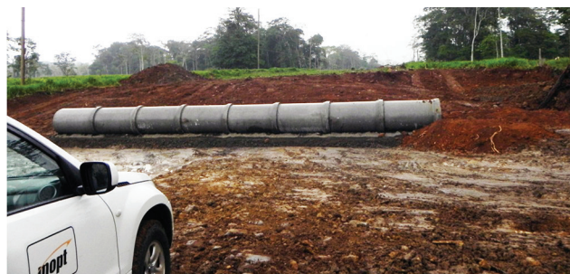
Colocación de alcantarillas
