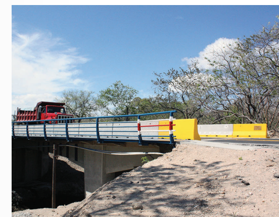
Puente sobre el río Azufrado
