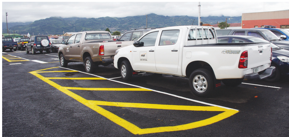
Parqueo del plantel central del MOPT
