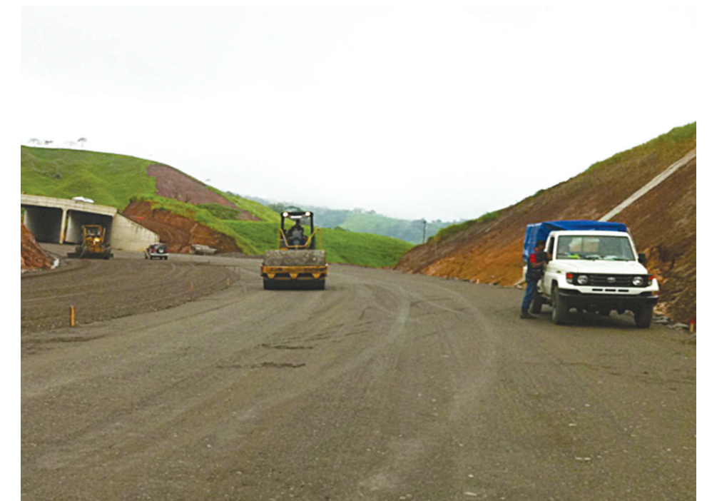
Colocación de sub-base
