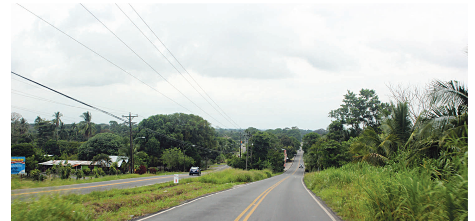
Colocación de carpeta en Canoas
