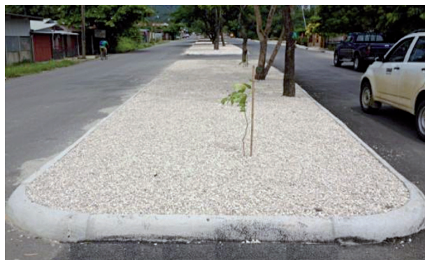
Reacondicionamiento de calzada: Boulevard San Martín.
