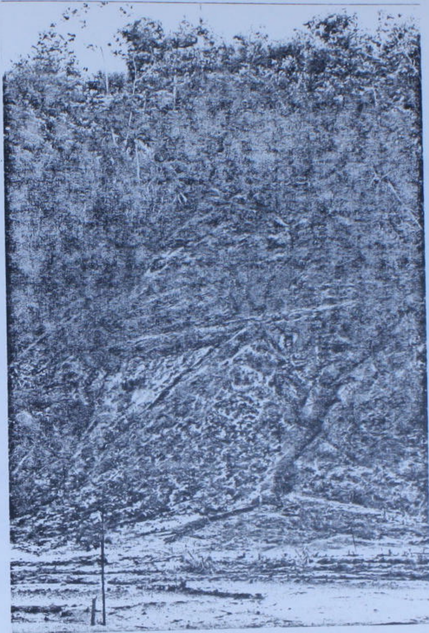
Fotografía # 6: Corte reciente sobre material profundamente meteorizado e inestable, el cual facilmente se desprende.
