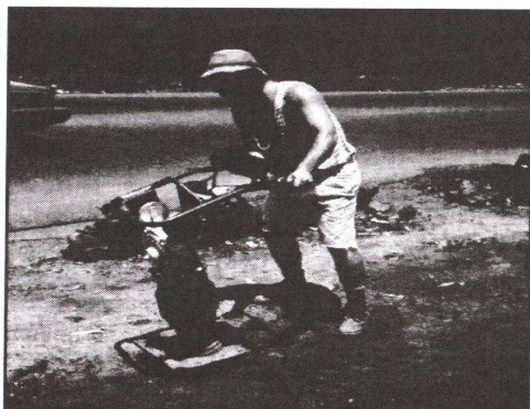
Foto 16: Compactación del material de relleno con un sapo brincón.
