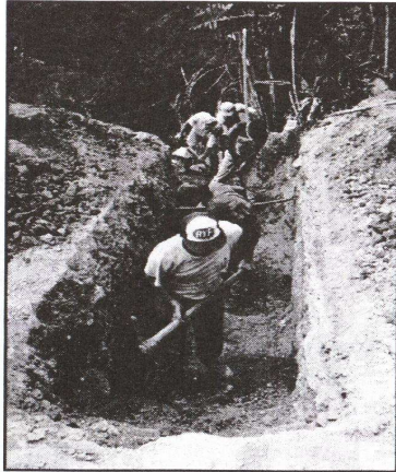
Foto 5. Excavación de una zanja a mano
