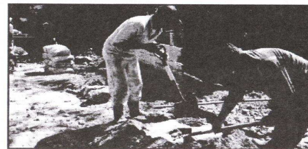
Foto 25: Concreto para cabezal mezclado a mano
