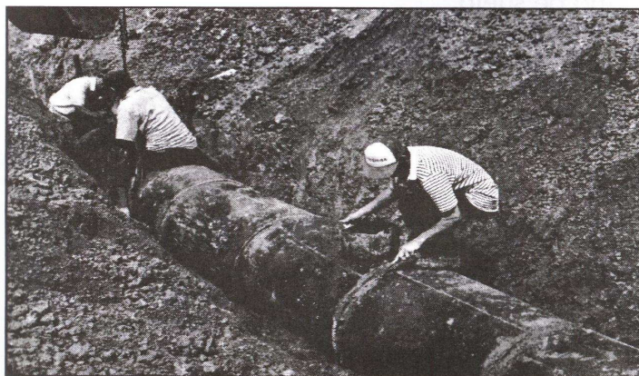
Foto 2: Colocación de tubos con ayuda comunal.
