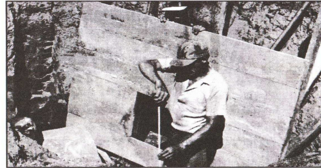
Foto 22: Formaleta exterior para un cabezal CA-1
