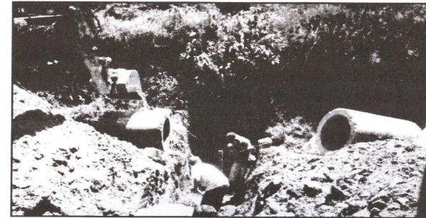
Foto 6. Trabajos de conformación de una zanja.
