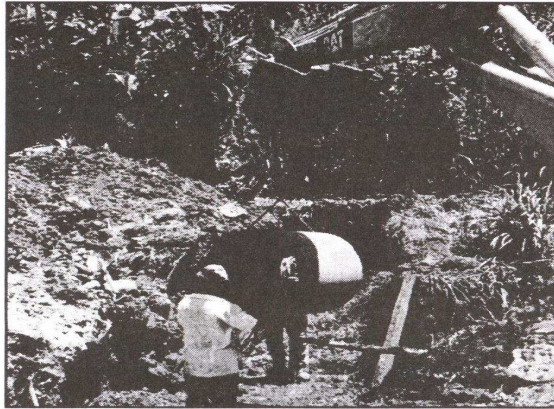
Foto 10: Los tubos se bajan a la zanja
