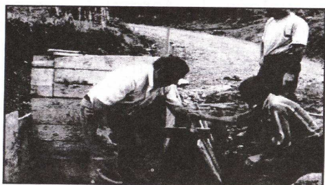
Foto 24: Formaleta exterior e interior para cabezal CA-6
