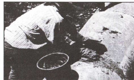
Foto 13: Relleno de juntas por la parte superior de los tubos
