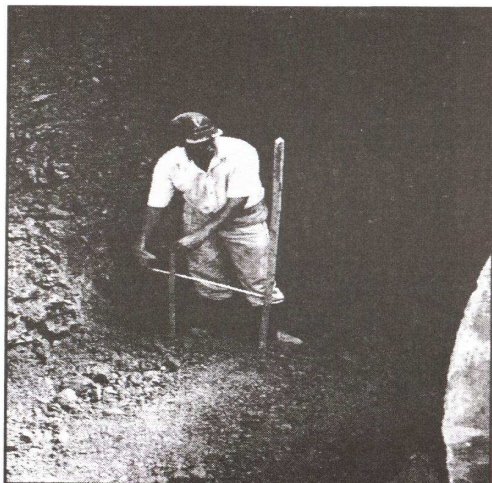
Foto 12: Colocación de estacas paralelas de alineamiento
