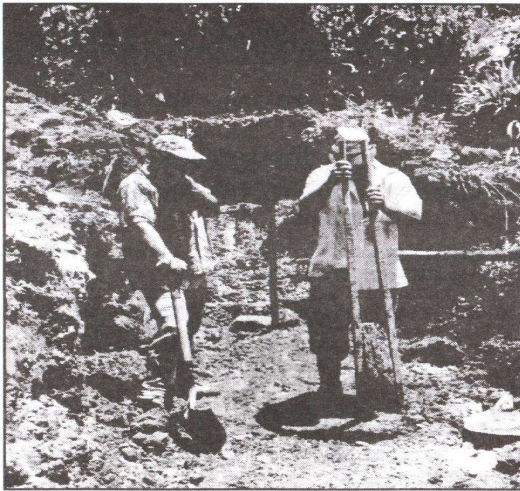
Foto 7: Compactación de la cama de la alcantarilla.
