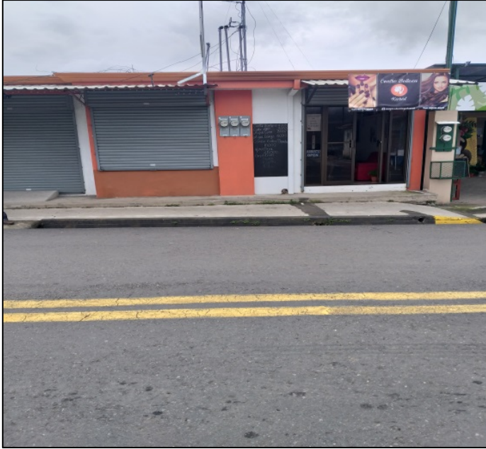
Figura N° 3 Costado este de la Calle 4, cordón amarillo borrado con pintura negra.
