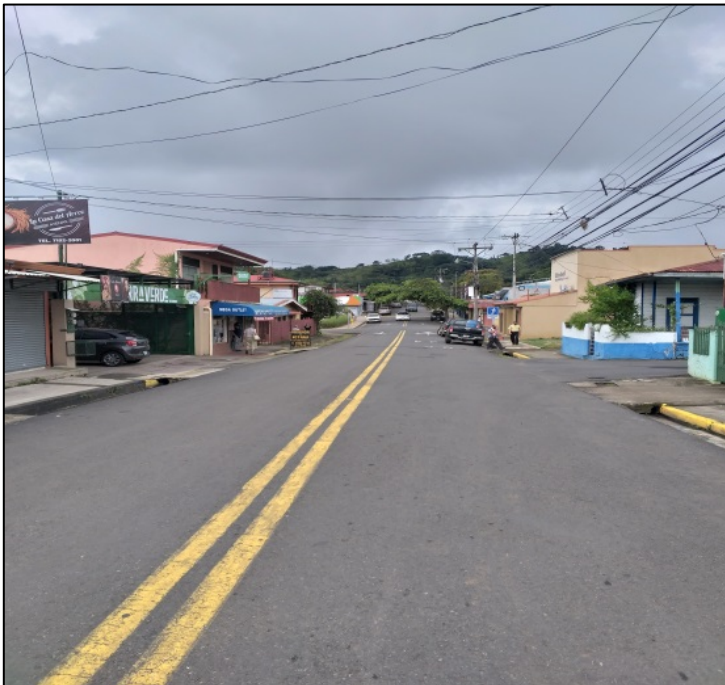
Figura N° 2 Sobre calle 4, sentido norte – sur y aceras existentes.
