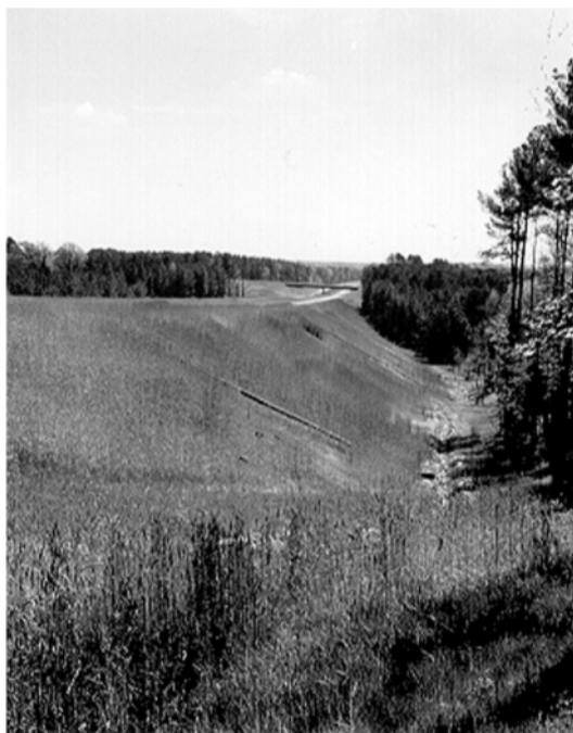
Fig. 6-2 Ejemplo de talud vegetado. (AASHTO, 2006)
