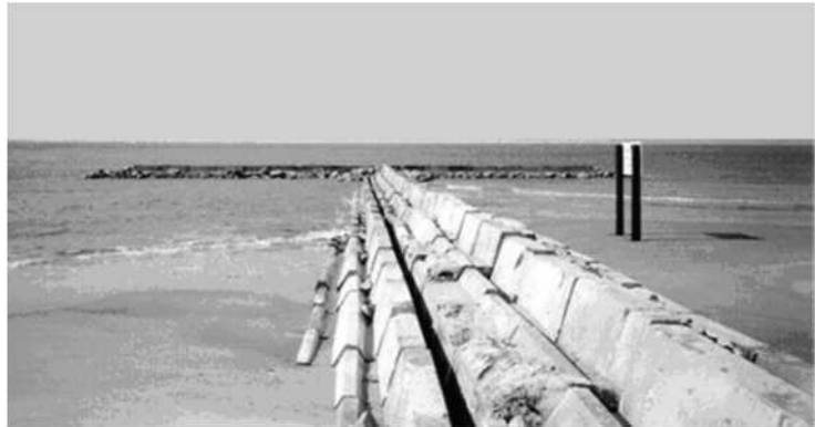
Fig. 6-9 Espigón de concreto con unidades prefabricadas. Extraído de (AASHTO, 2006)
