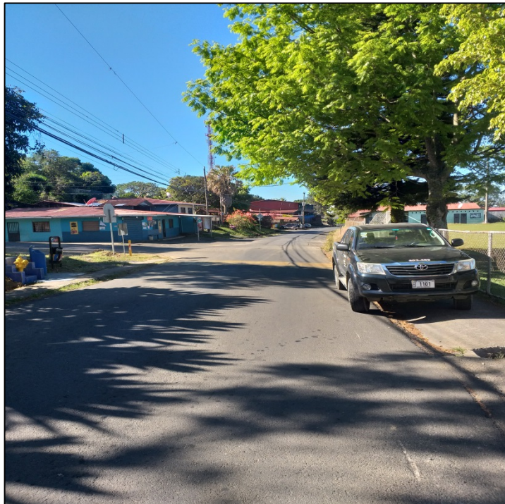
Figura N° 3 Calle San José, sentido sur – norte sin demarcación
