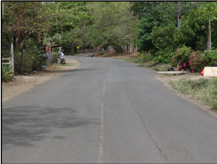
Imagen N° 2. Tratamiento superficial Ruta Nacional N° 911.
