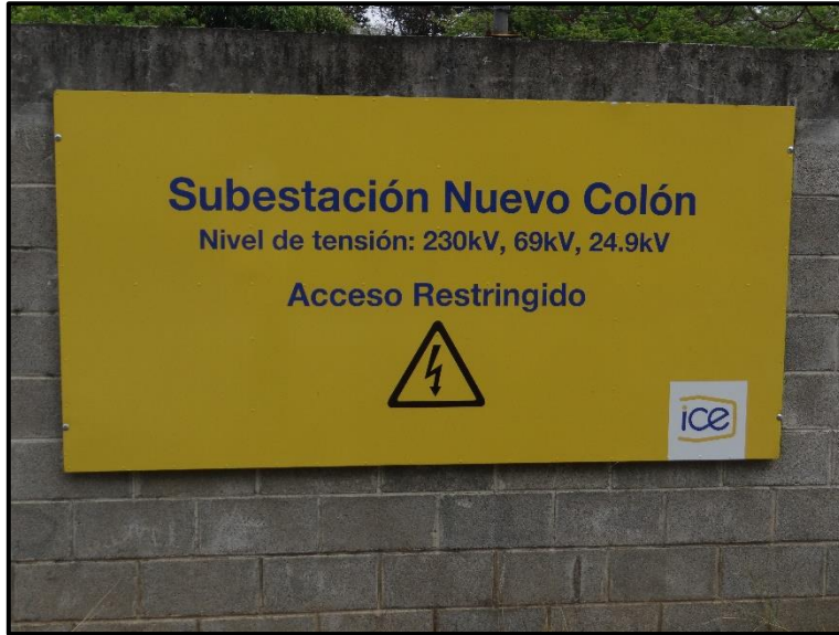
Imagen N° 3. Subestación ICE, Nuevo Colón.
