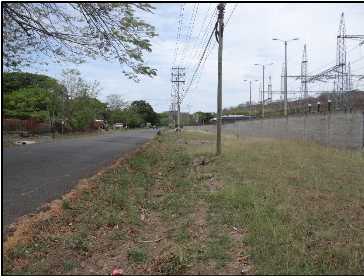
Imagen N° 4. Falta de acera.
