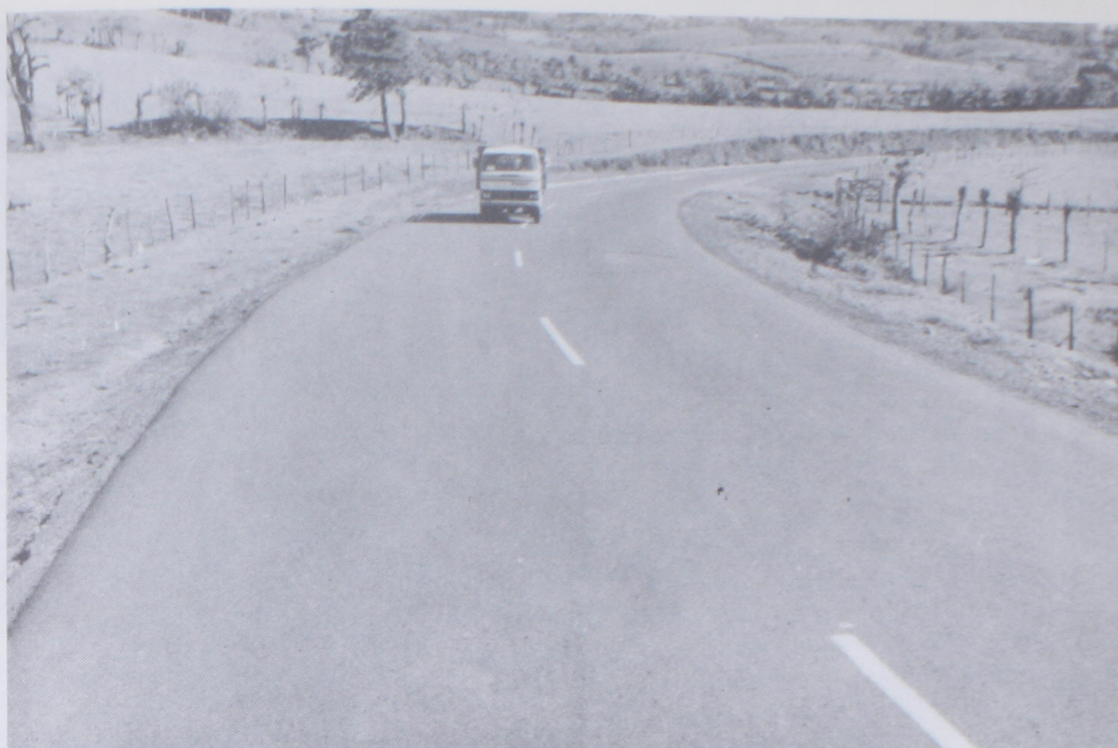
El Proyecto Cartago - Tierra Blanca se encuentra totalmente terminado y demarcado.
