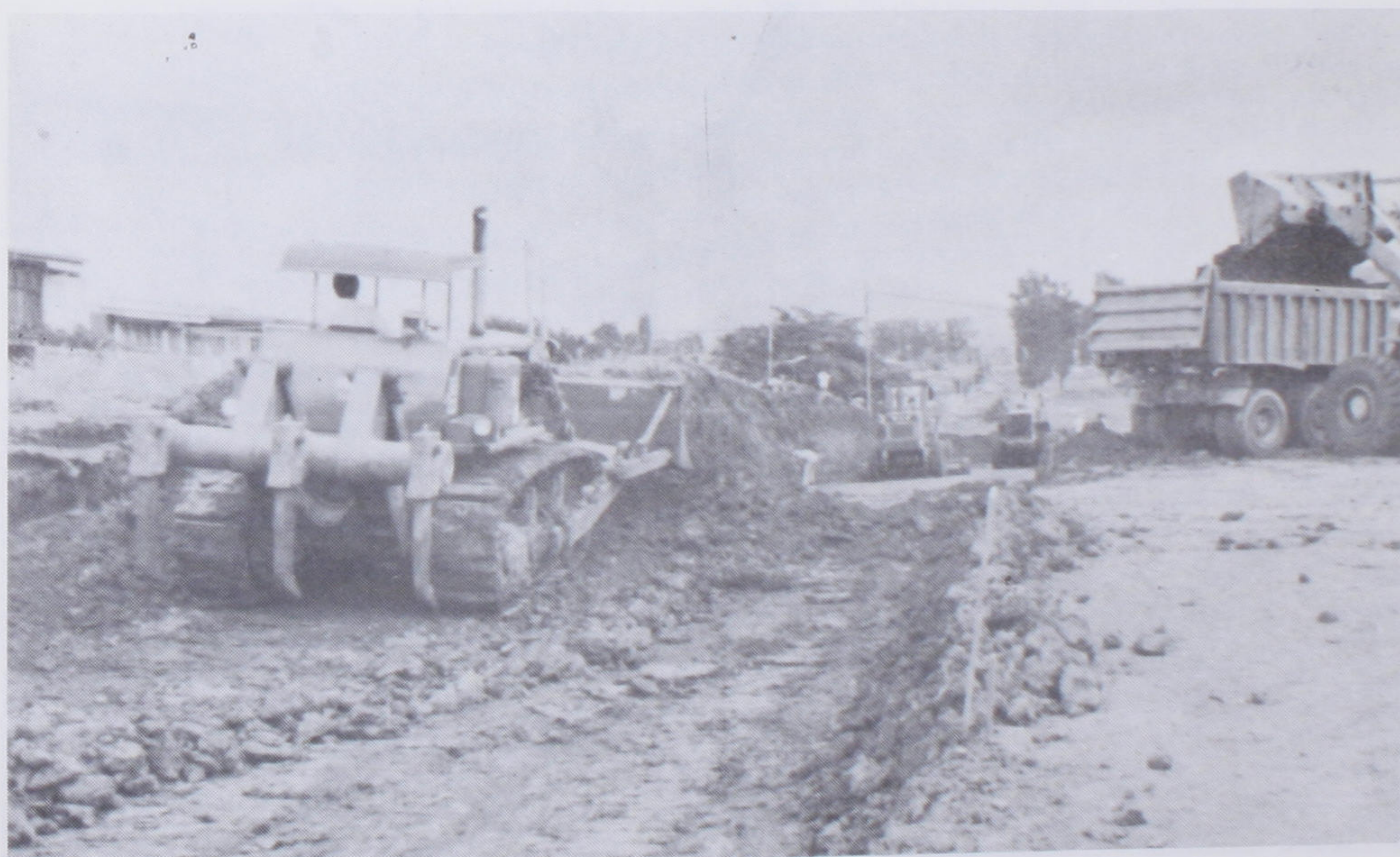
Parte de las obras que se realizan en la construcción del proyecto de la carretera Periférica, que une a Hatillo con Guadalupe.
