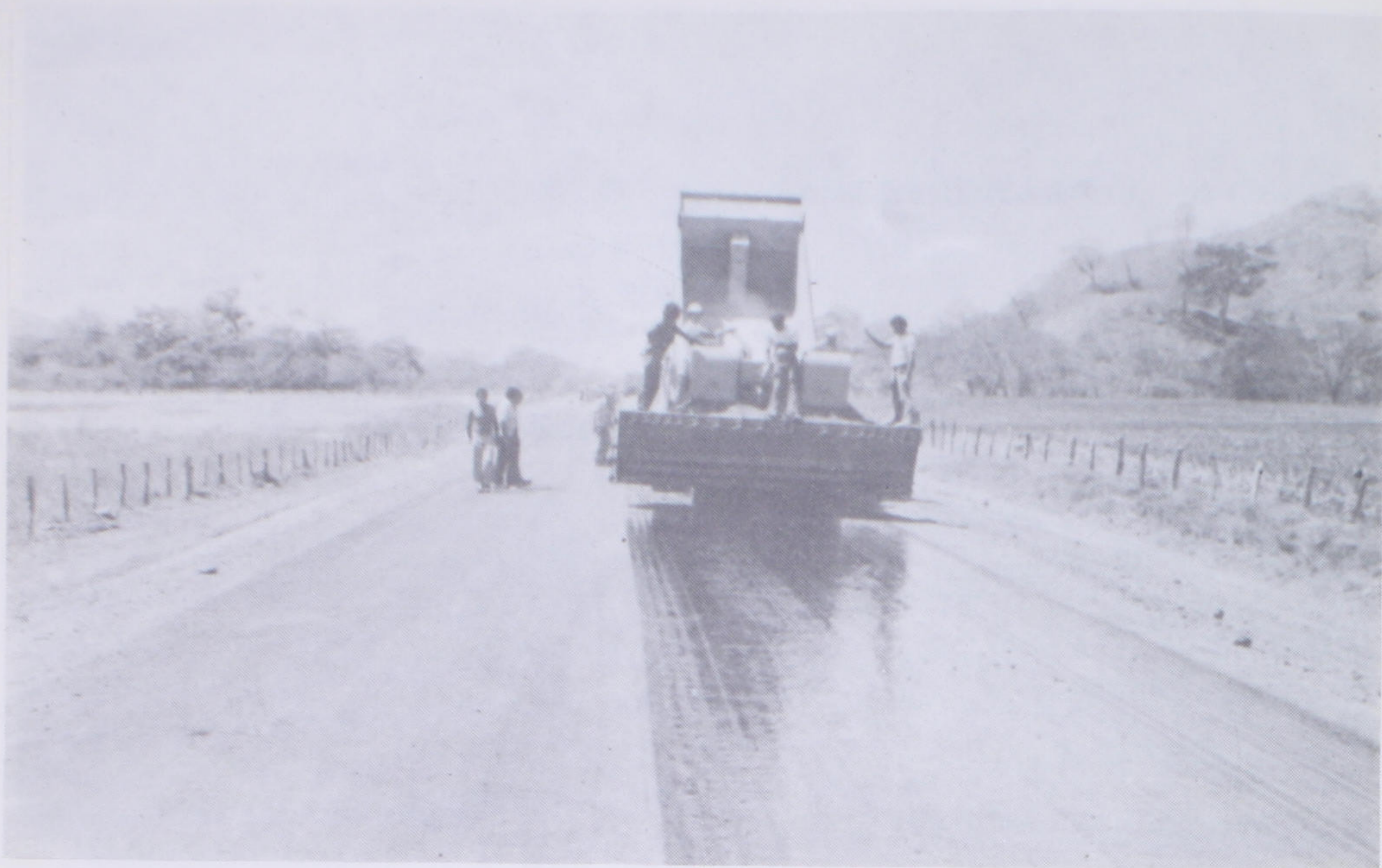
Parte de los trabajos que se llevan a cabo en la última etapa de construcción del proyecto Interamericana - Cuajiniquil
