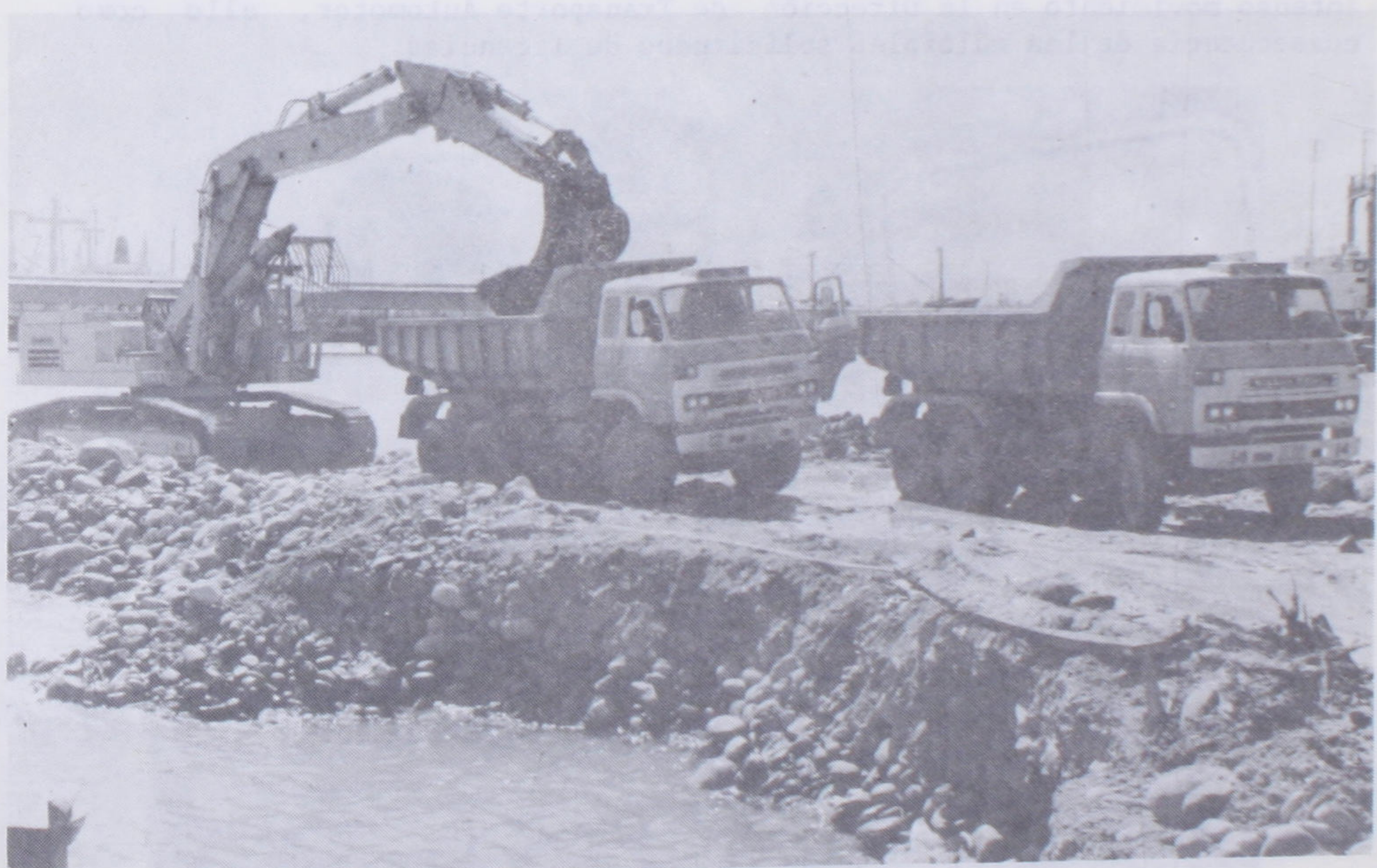
Trabajos que se realizan en la construcción del Proyecto Alemán, en Limón.
