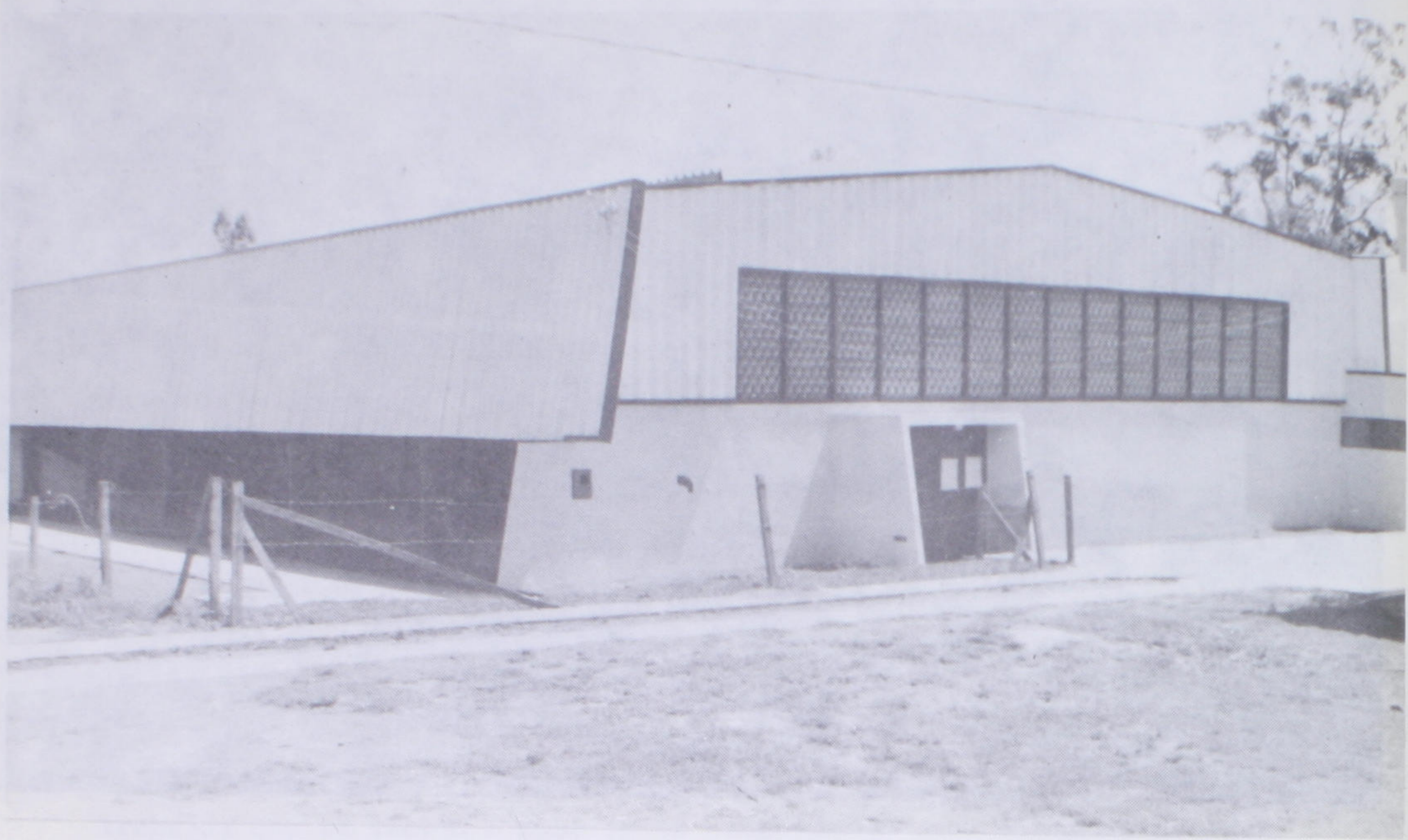
Construcción de un gimnasio prefabricado en el Colegio Vicente Lachner.
