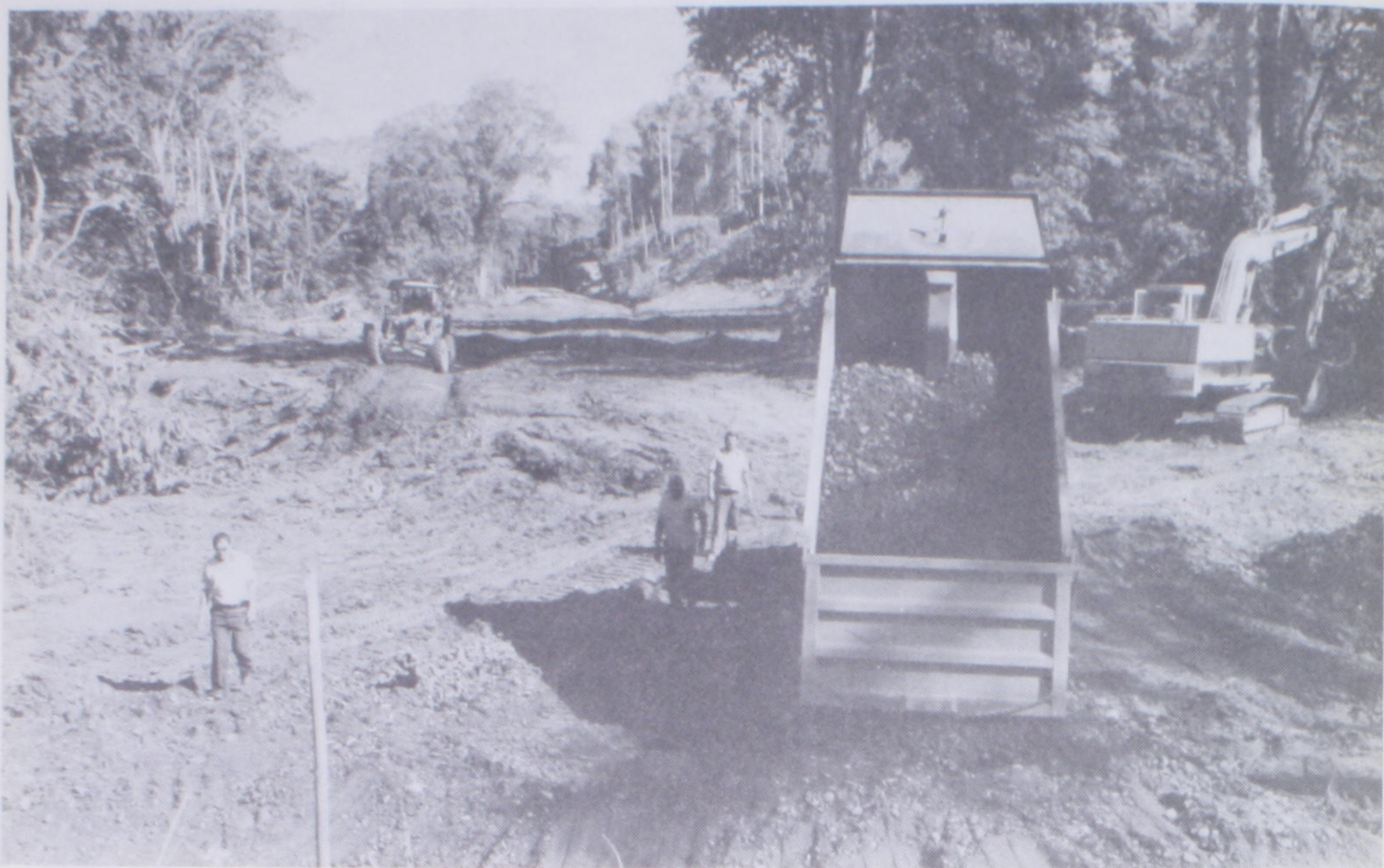
Trabajos que se llevan a cabo en la construcción del proyecto Bri-Brí.
