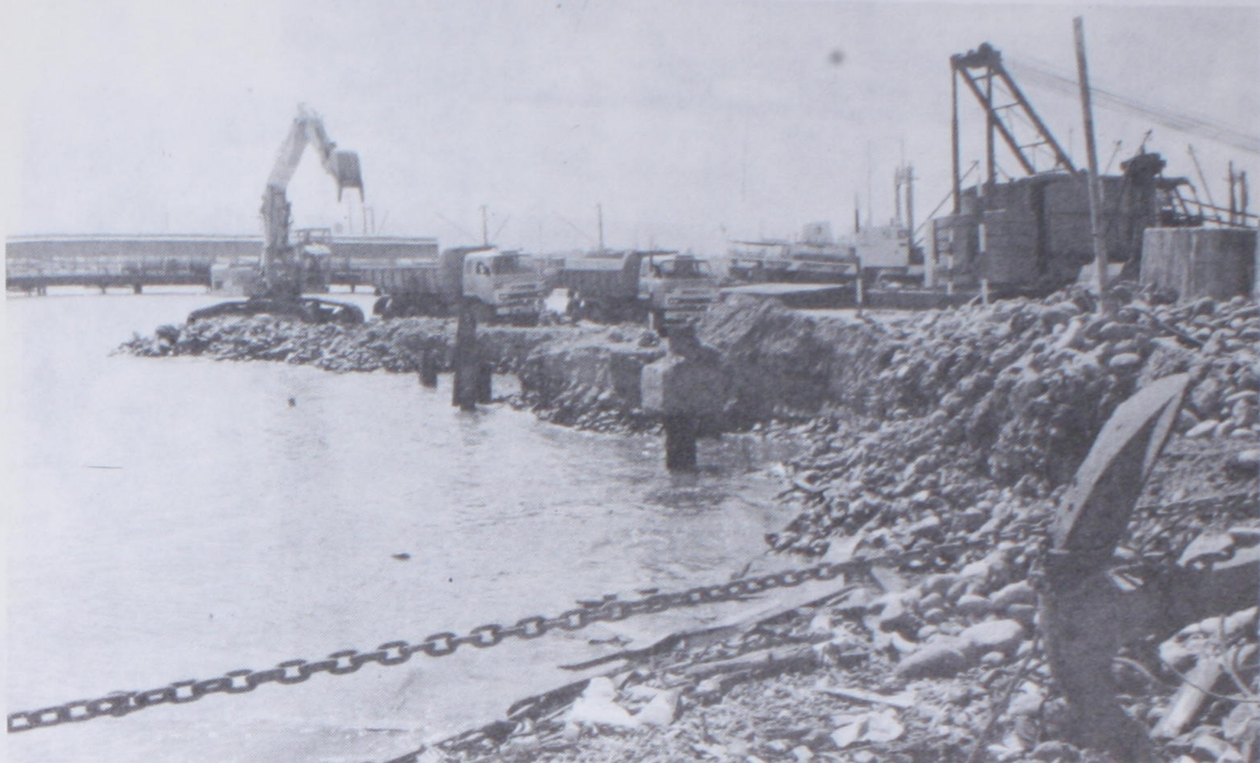
Vista parcial de la construcción del Proyecto Alemán, en Limón
