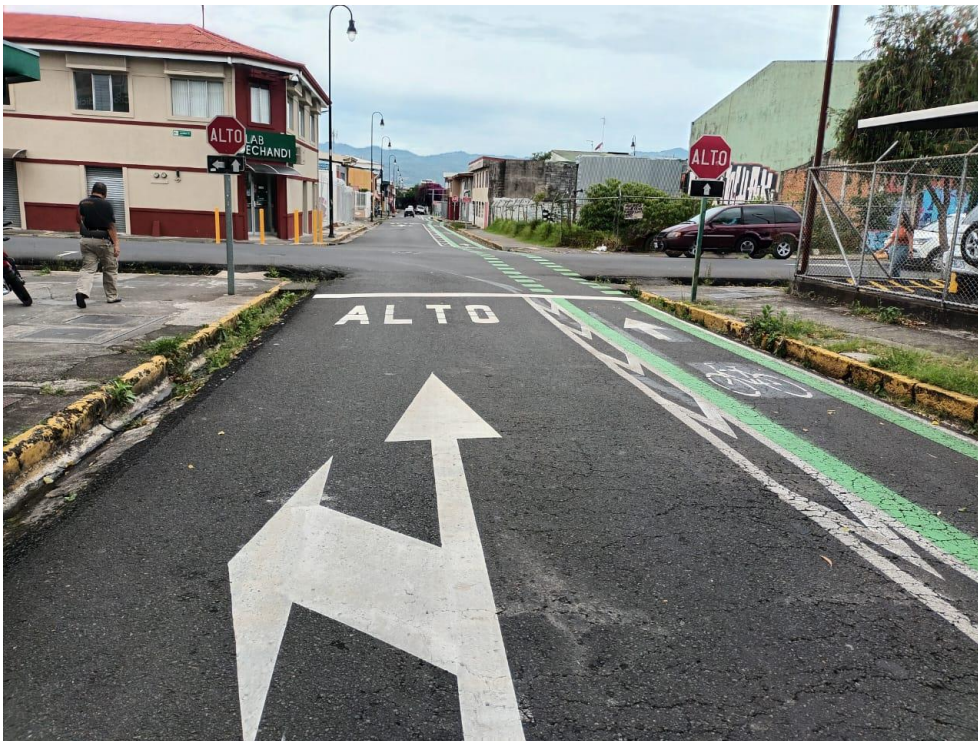
Figura 3 Vista sur de acceso norte de intersección RT N. ° 10104 – Calle 13A, Catedral, San José. Fuente: (Piedra, 2023).
