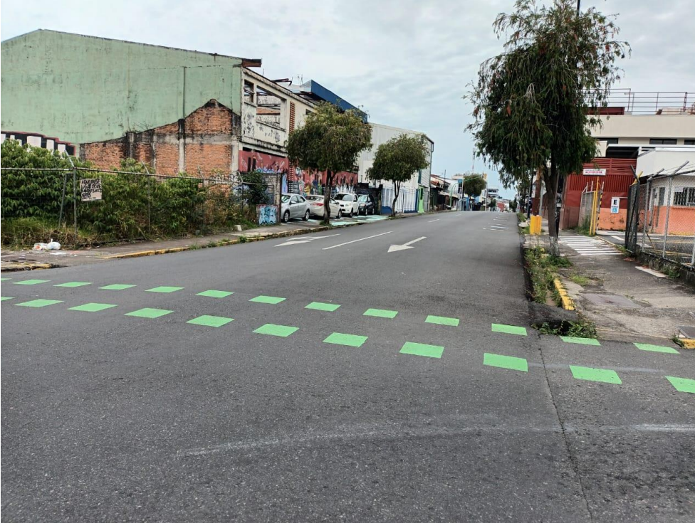
Figura 4 Acceso oeste intersección RT N. ° 10104 – Calle 13A, Catedral, San José. Fuente: (Piedra, 2023).
