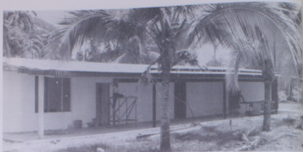
COLEGIO AGROPECUARIO DE CORREDORES. — Pabellón de aulas del Colegio Agropecuario de Corredores, que construye el MOPT por medio de la Dirección General de Edificaciones Nacionales. El trabajo consiste en la conclusión de todas sus instalaciones, y el costo de la obra se estima en dos millones de colones.
