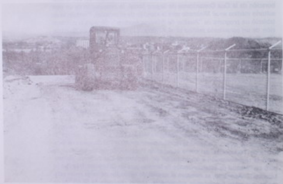
La Dirección de Aviación Civil construye una calle perimetral externa en el Aeropuerto Juan Santamaría, la cual servirá de acceso a COOPESA Automotriz, la Curtidora y la Base Dos.
