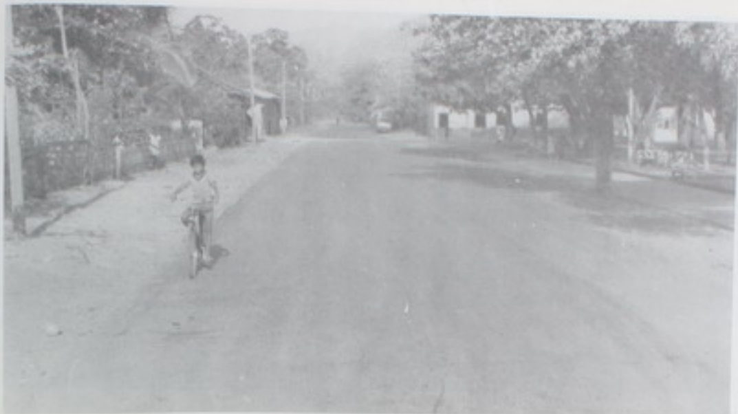
Las principales vías de la localidad de Sardinal de Guanacaste, fueron asfaltadas por el Ministerio para facilitar el tránsito de vehículos.
