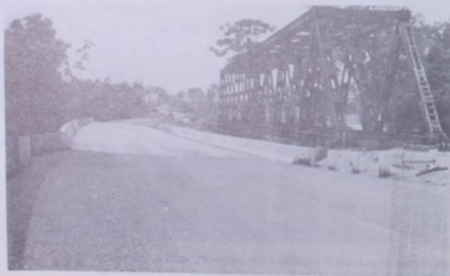
Puente sobre el Río Corinto que construyó el MOPT en el tramo de carretera Guápiles - Río Sucio.
