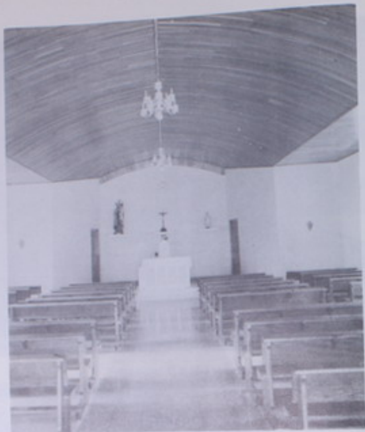
La Dirección de Ayuda Comunal procedió a remodelar los cielos en la Iglesia de Barrio San José de Atenas.
