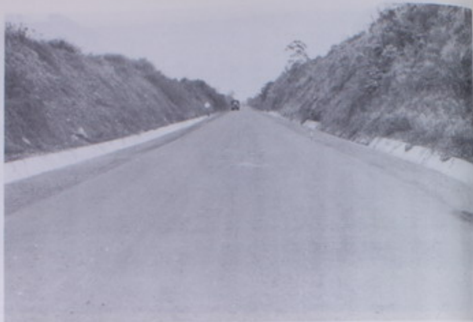
Panorámica del tramo de carretera Guácimo-Río Jiménez, que forma parte de la importante vía que unirá a San José con Limón, mediante la cual se agilizará notablemente el tránsito de vehículos a la Vertiente Atlántica.
