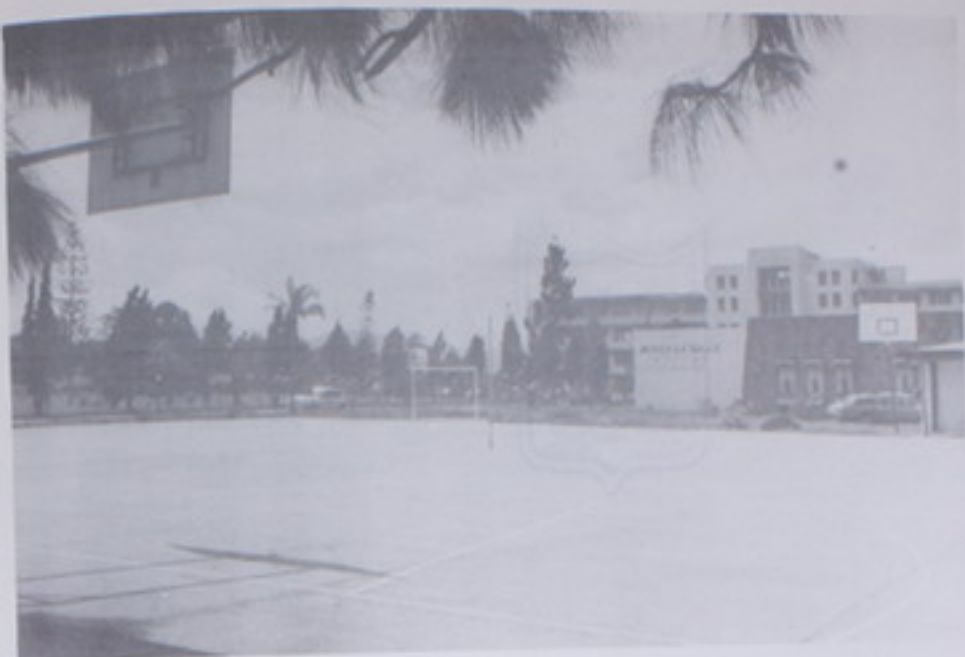
Cancha de baloncesto ubicada en las instalaciones del Ministerio de Agricultura y Ganadería, que construyó el MOPT por medio de la Dirección de Ayuda Comunal.
