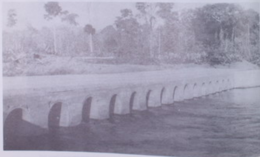
VADO CONSTRUIDO EN EL PROYECTO INTERAMERICANA- RINCON DE OSA
