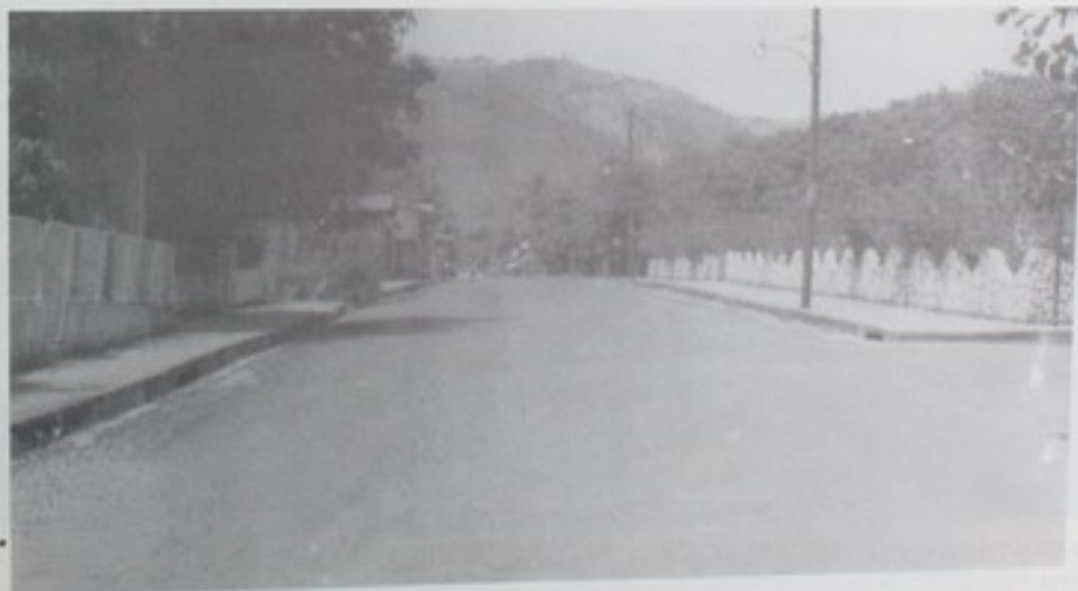
El asfaltado de las calles de la localidad de Portegolpe, en Guanacaste, es otro de los importantes trabajos que llevó a cabo Obras Públicas, para beneficiar a los pobladores de las comunidades de esa provincia.
