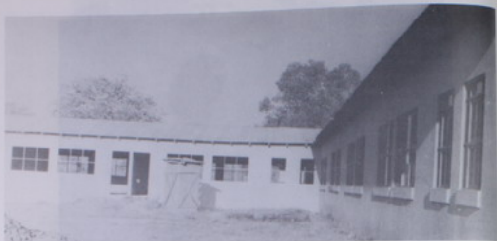
Muy avanzada se encuentra la construcción del Liceo Nocturno de Liberia, que realiza la Dirección de Edificaciones Nacionales.
