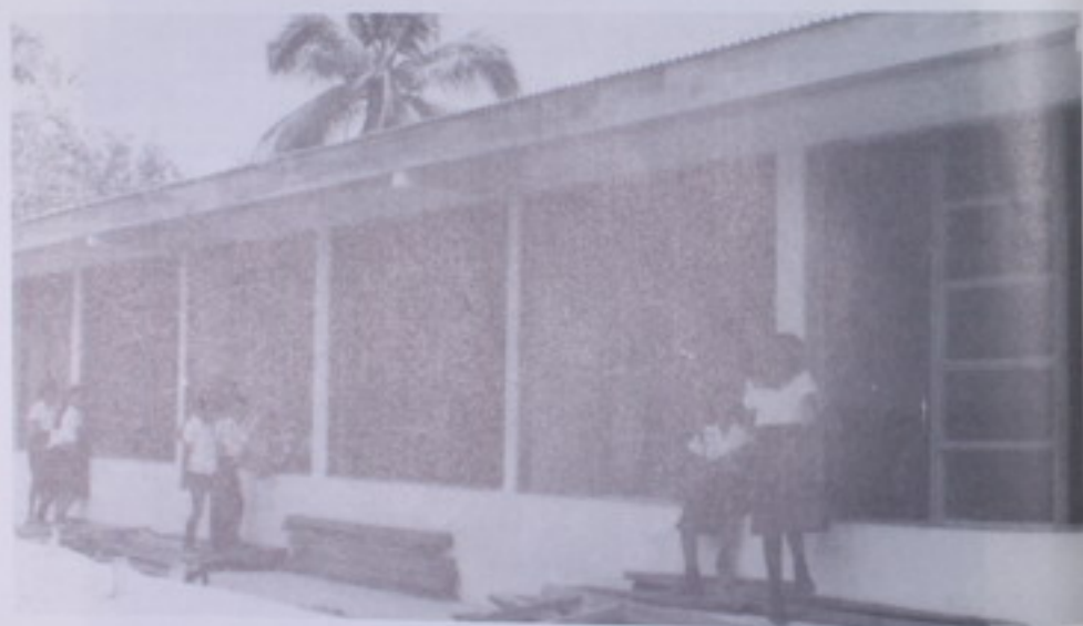
Como parte de la importante labor que desarrolla la Dirección de Edificaciones Nacionales, para dotar de mejores condiciones a los Centros Educativos de todo el país, está la Escuela que se construye en Sámara de Guanacaste.
