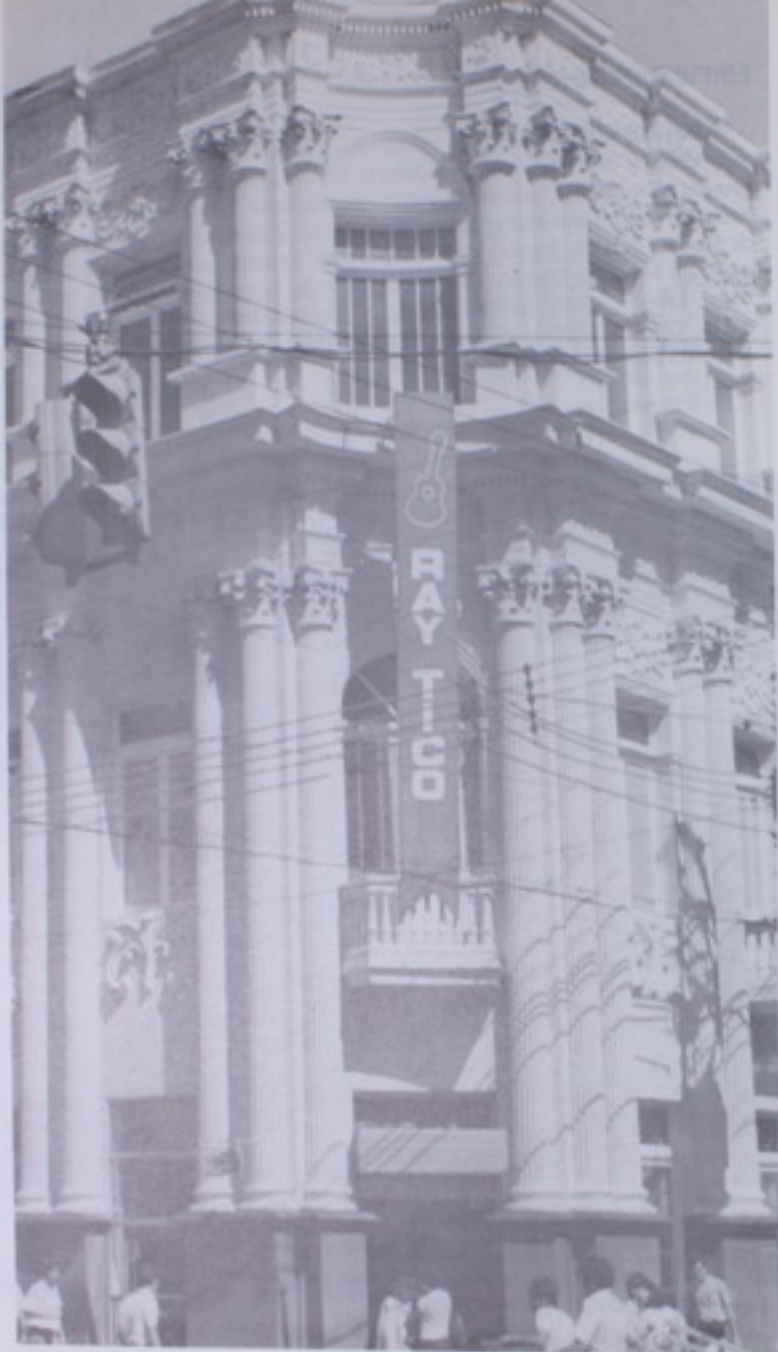
Se aprecia el Teatro Melico Salazar, cuya reconstrucción la realizó el MOPT por medio de la Dirección General de Edificaciones Nacionales. Para la reconstrucción de este Teatro, el Ministerio aportó en los últimos dos años 56 millones de colones, que incluyen la mano de obra, materiales, mobiliario y equipo.
