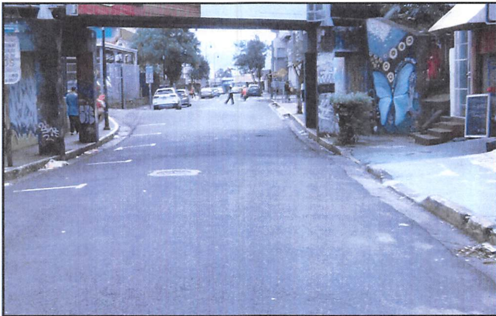
Figura 3 Acceso de entrada Calle 15, con Zona de Estacionamiento Vehicular, donde el ancho de calzada se encuentra estrangulado a un solo carril vehicular y los espacios de estacionamiento poseen un ancho inferior a los 2.5 metros, vista Norte Sur.
