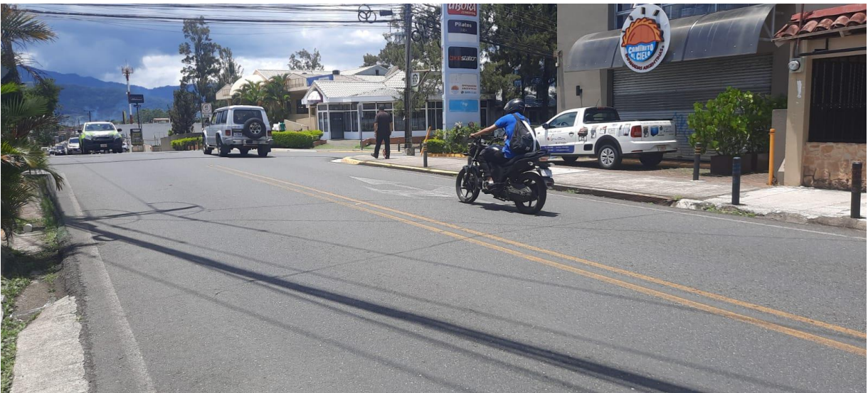
Figura 2 Acceso norte de intersección RT N. ° 11801 – RT N.° 11807, Curridabat, San José. Fuente: (Propia, 2023).
