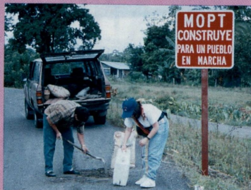
Personal del Departamento de Proyección Institucional en la colocación de letreros en los distintos proyectos carreteros
