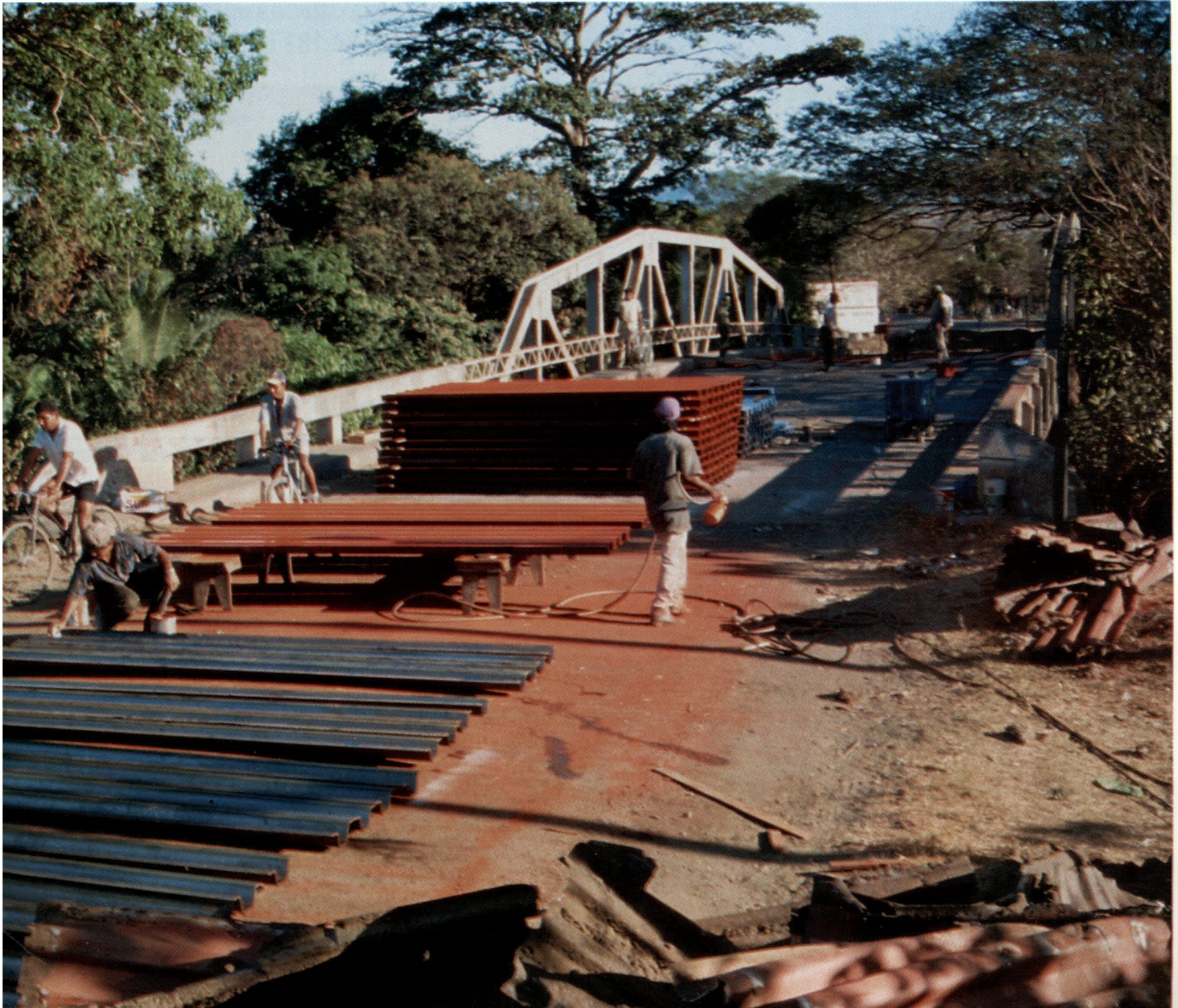
Puente en construcción sobre la carretera Santa Cruz-Nicoya
