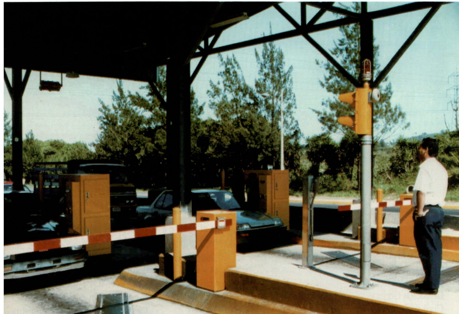
Estación de peajes, con máquinas para el cobro automático, en la carretera a Cartago
