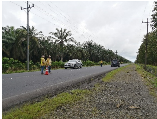
Figura 2. Punteo de centro de la calzada
