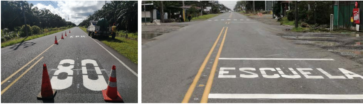
Figura 7. Demarcación de letreros y sendas peatonales.
