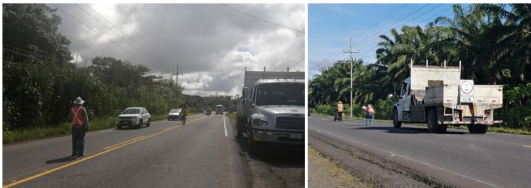
Figura 8. Colocación de captaluces.
