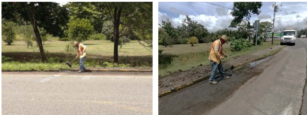
Figura 9. Labores de limpieza.
