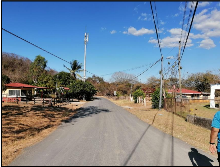
Imagen N° 2. Tratamiento superficial bituminoso en la zona.
