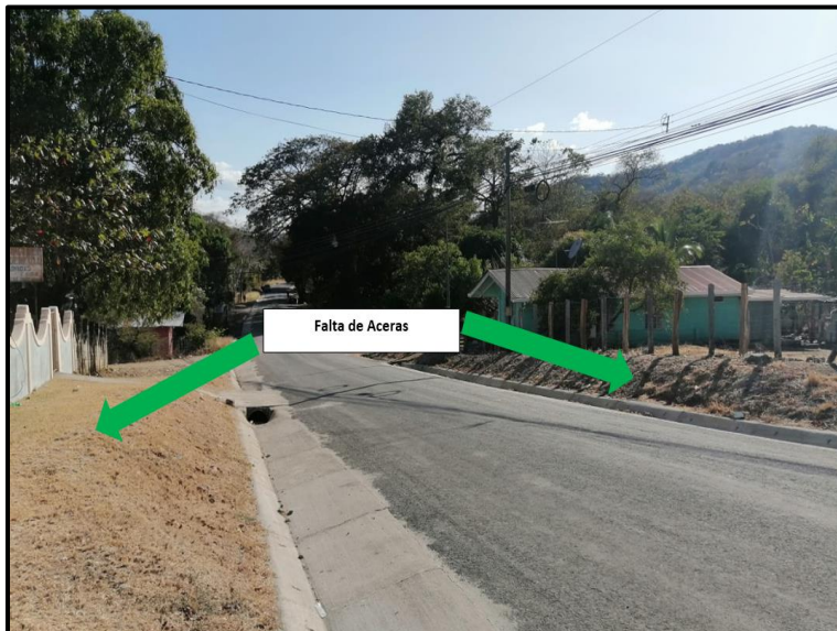
Imagen N° 4. Falta de acera.
