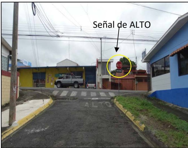
Figura N° 4 Señal vertical de ALTO y señalamiento borroso.
