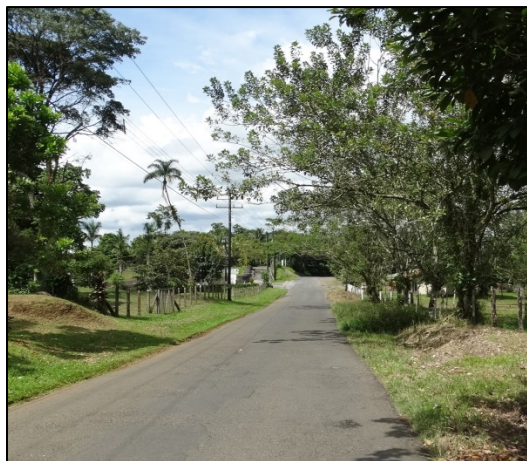
Figura N° 2. No hay aceras, ni señalamiento vial
