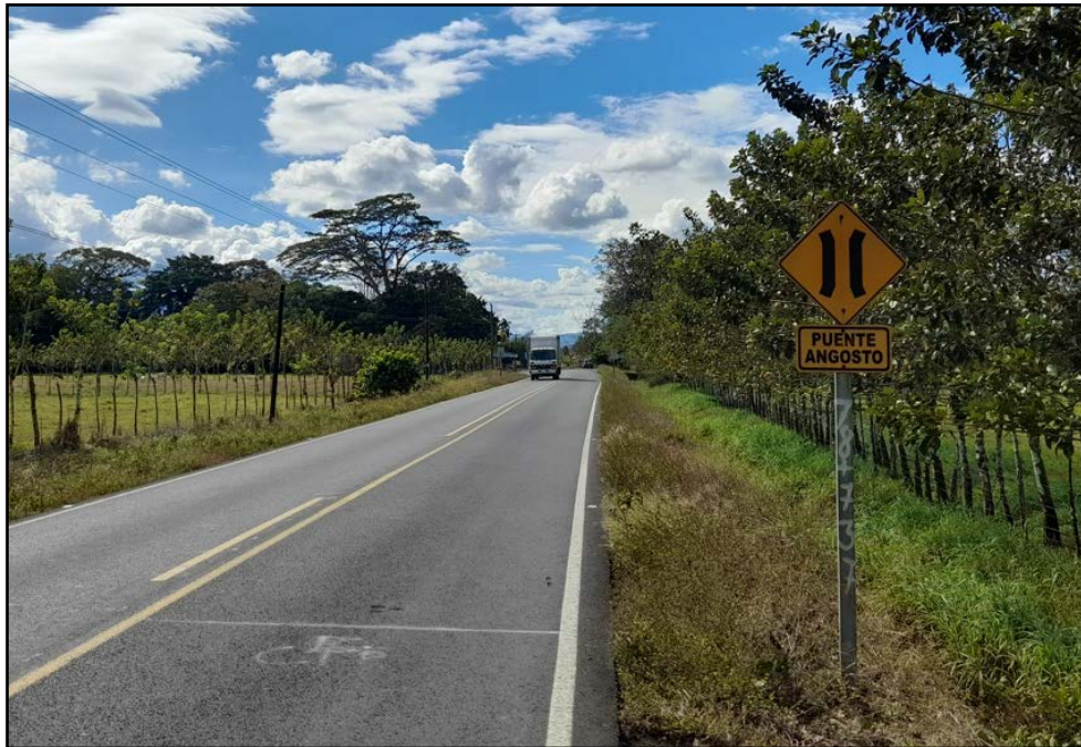
Figura 4. Señal de PUENTE AGOSTO en sentido La Vega – La Perla
