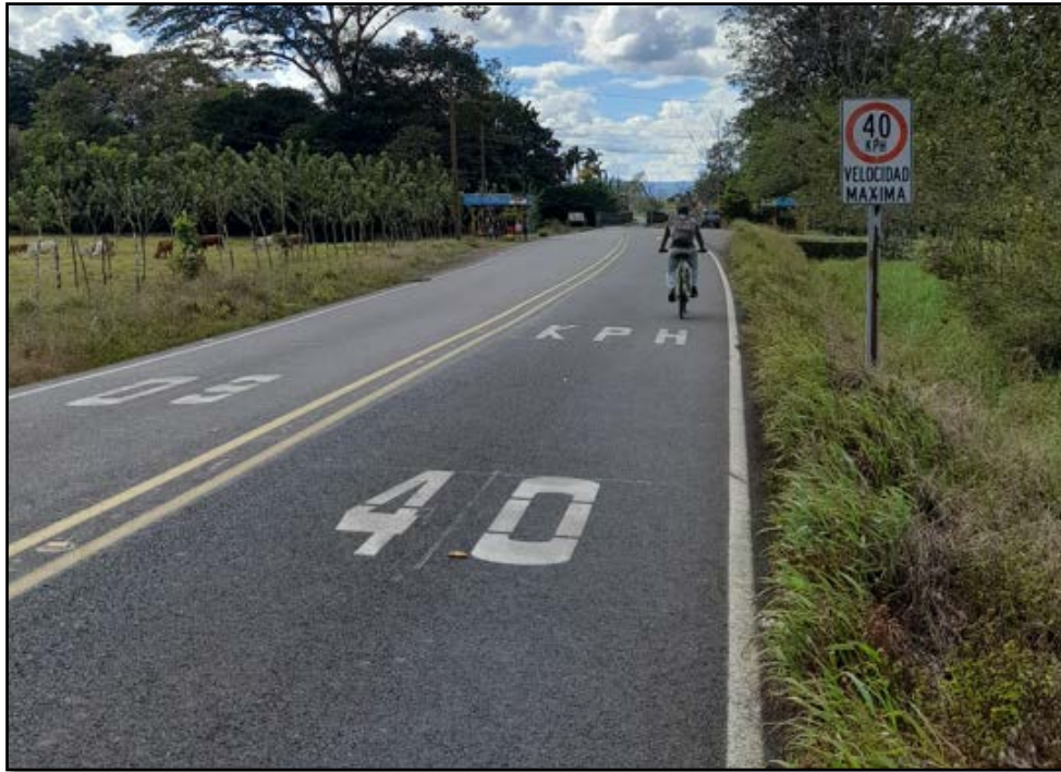
Figura 7. Señal de velocidad 40 KPH VELOCIDAD MÁXIMA en el ingreso al puente, sentido La Vega – La Perla
