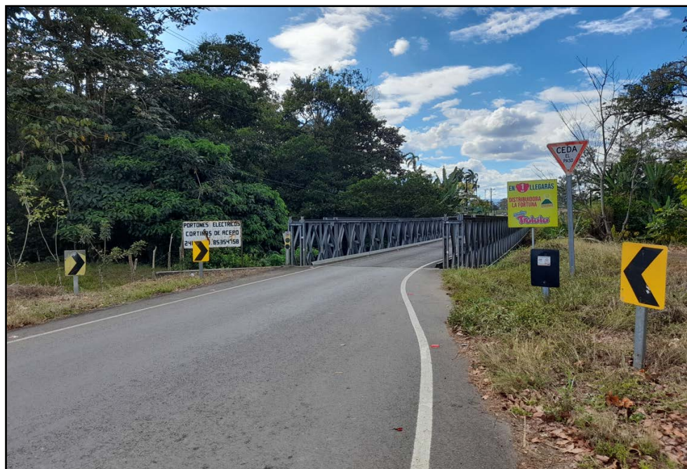
Figura 6. Señales tipo CHEVRON y señal de CEDA EL PASO en sentido La Vega– La Perla
