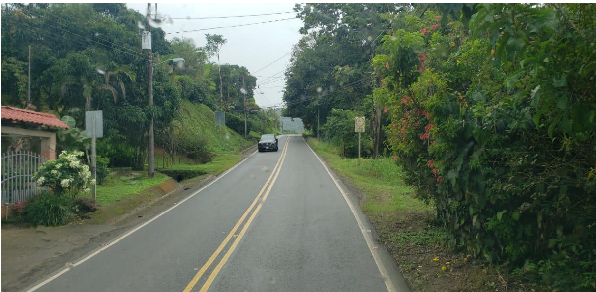
Figura 2. Demarcación de la vía y señalización de 40 km/h viniendo de Dominical
