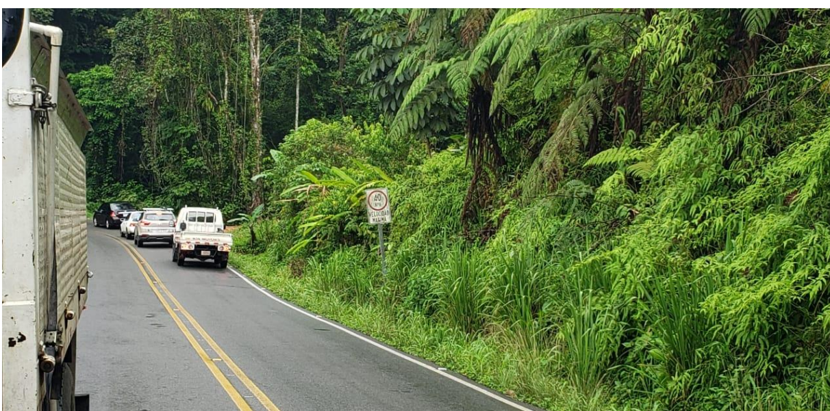
Figura 3. Demarcación de la vía y señalización de 40 km/h viniendo de Pérez Zeledón
