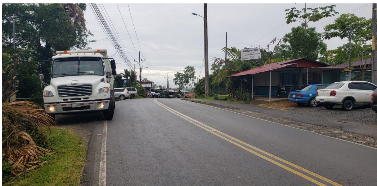
Figura 5. Tramo de carretera frente a la Escuela José María Chaverri Picado
