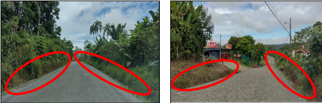
Imágenes 4 y 5. Zona de estudio RN N° 327 falta de aceras.
