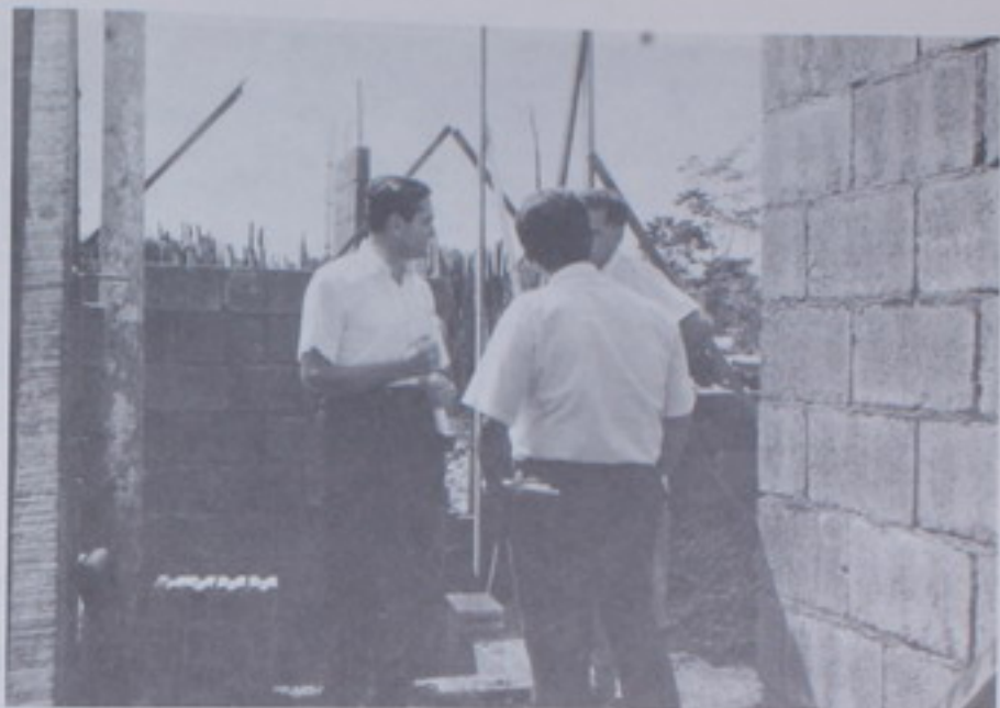
Unidad Sanitaria de San Carlos
