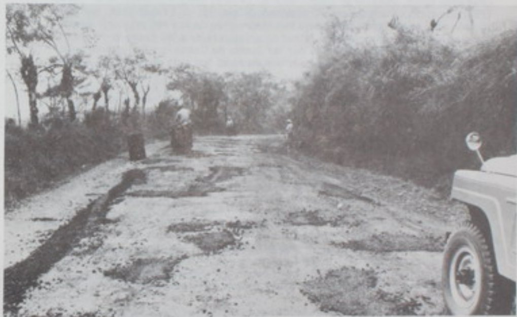
Mantenimiento en Turrialba
