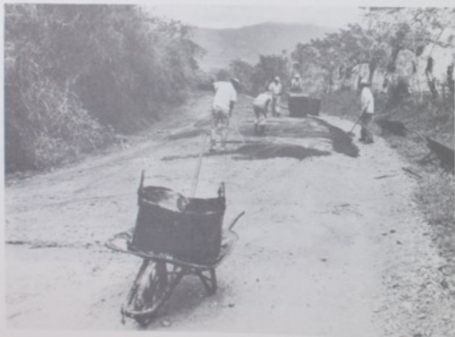
Mantenimiento en Turrialba
