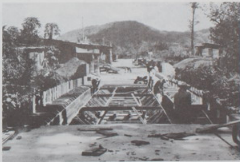
Puente La Lima sobre Carretera Santa Cruz-Playas de Tamarindo
