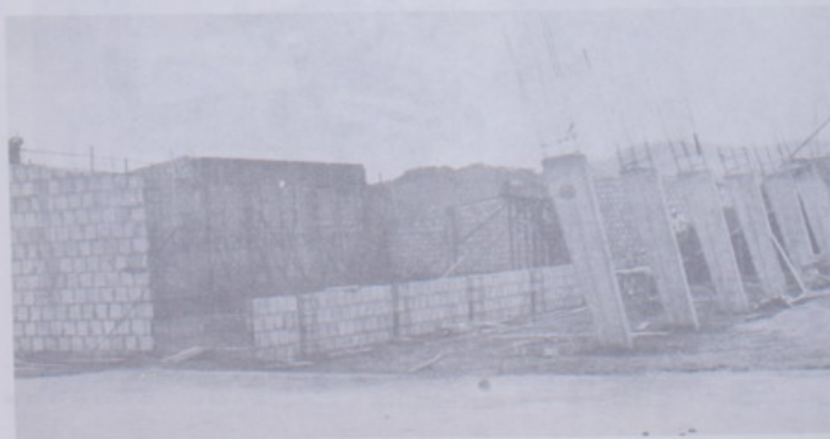
Gimnasio del Colegio Monseñor Rubén Odio en Construcción
