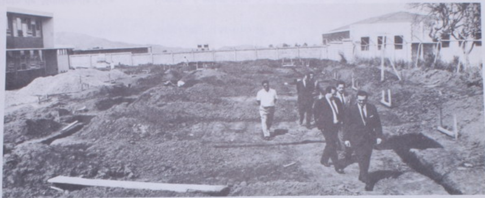
Visita de Inspección al Colegio Luis Dobles Segreda
