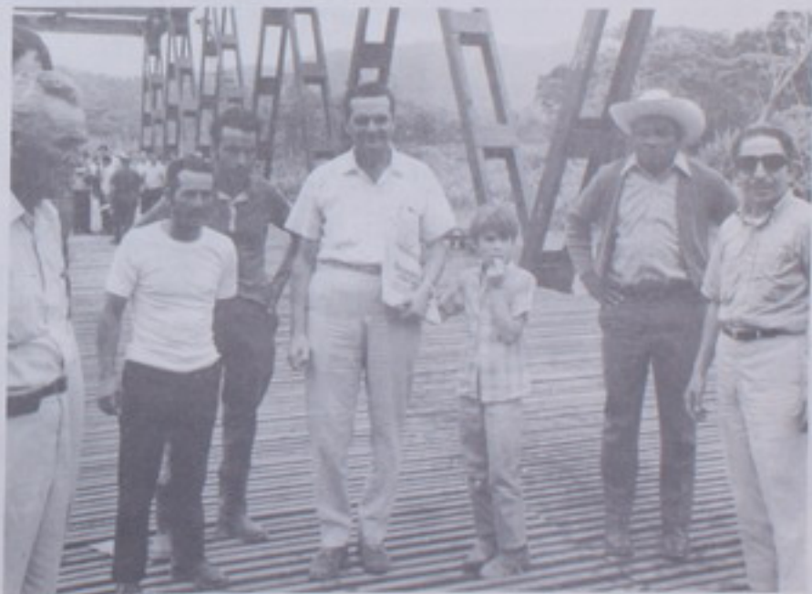
Apertura de la Vía Provisional a Limón (Puente Chirripó)
