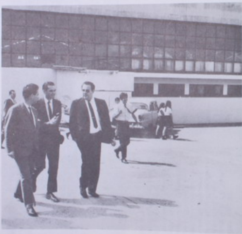
Visita de Inspección al Colegio Luis Dobles Segreda
