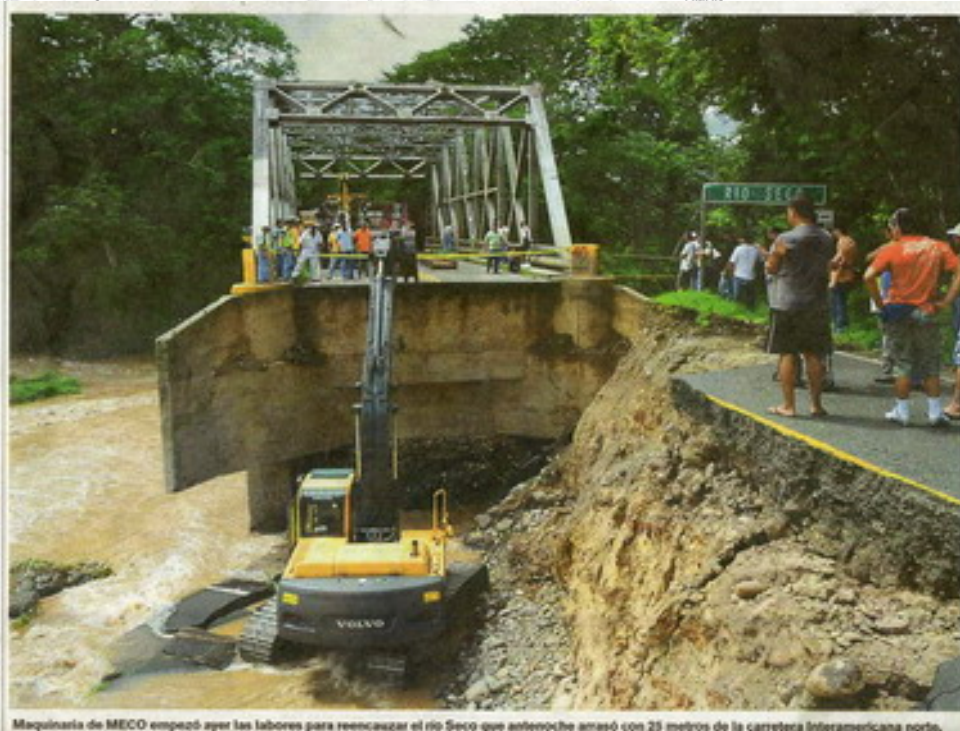
Maquinaria de MECO empezó ayer las labores para reencasar el río Seco que anteañocho arrasó con 25 metros de la carretera Interamericana norte.
