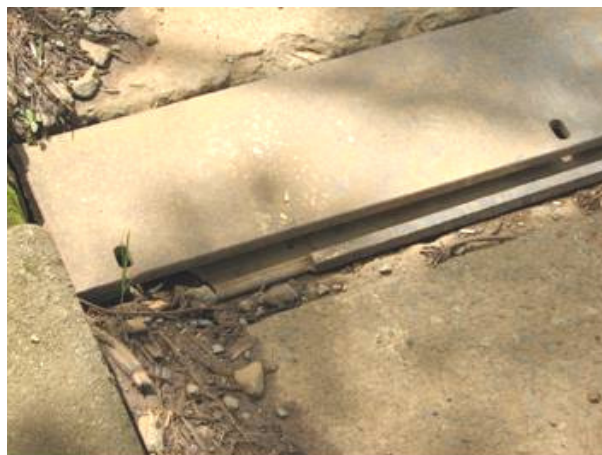
Figura 6-12 Movimiento vertical de la junta de expansión
