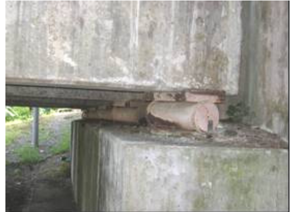
Figura 1.25 Apoyo expansivo tipo rodillo
