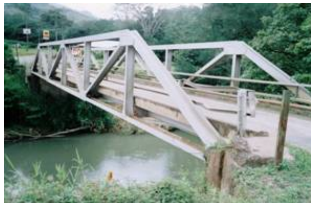
Figura 1.18 Puente tipo pony
