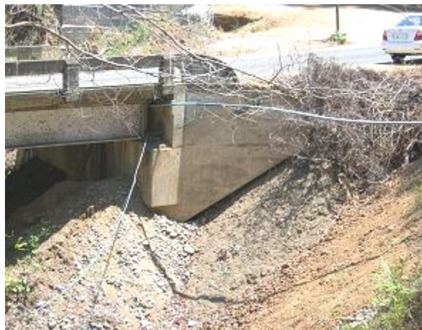
Figura 6-38 Relleno de aproximación
