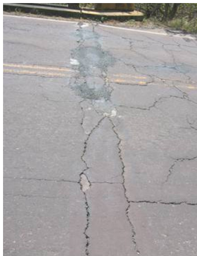
Figura 6-13 Sobrecapas sobre las juntas de expansión (grado 5)
