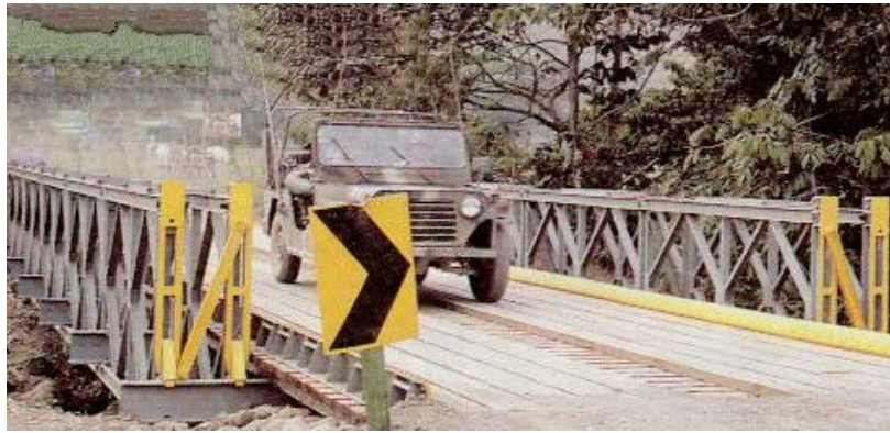
Figura 1.17 Puente tipo bailey
