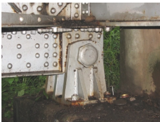
Figura 1.27 Apoyo fijo de acero
