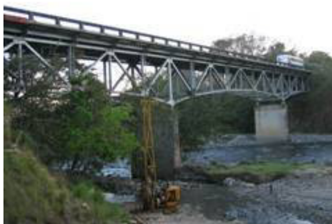
Figura 1.16 Cercha paso superior
