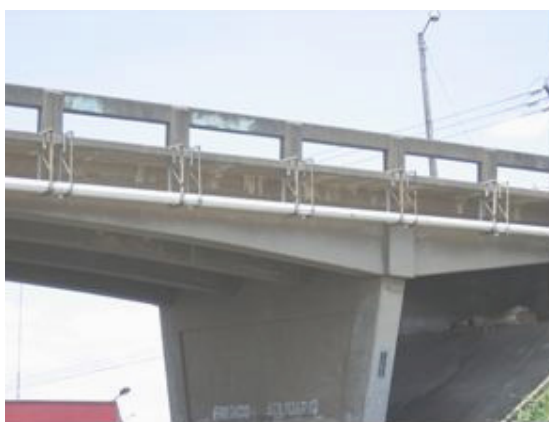
Figura 1.29 Apoyo rígido (concreto)
