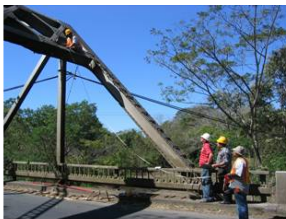
Figura 2-8 Actividades de inspección en alturas
