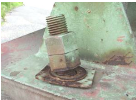
Figura 6-33 Deformación del perno
