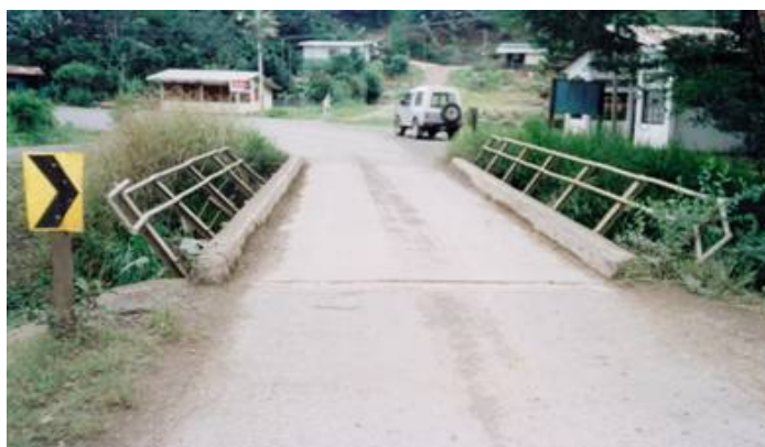
Figura 6-5 Deformación de la baranda (grado 5)
