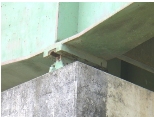
Figura 6-37 Movimiento del apoyo (grado 5)
