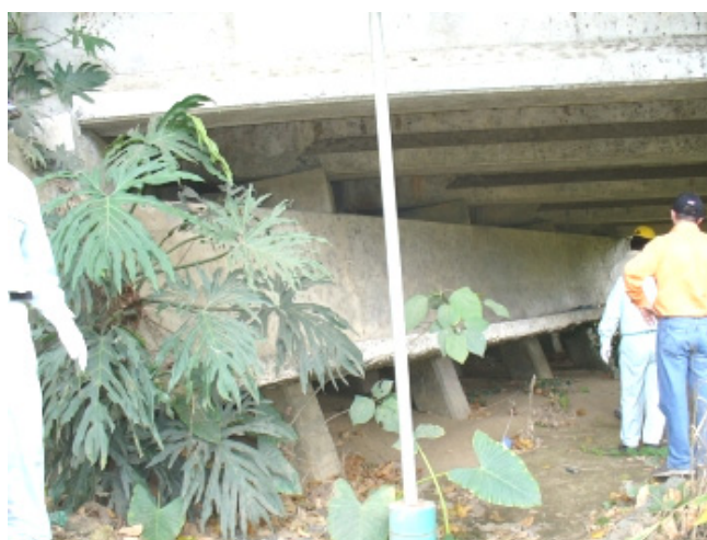
Figura 6-40 Inclinación del bastión por sismo (grado 5).
