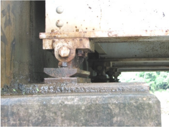
Figura 1.24 Apoyo expansivo tipo patín
