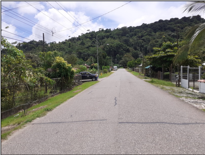
Figura 2. Tramo Ruta Nacional N° 238, sentido hacia Golfito.
