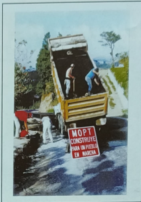
Las obras, actualmente en ejecución favorecerán fundamentalmente al sector productivo en el cantón de San Carlos.
