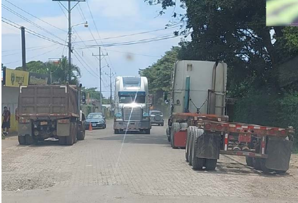
Figura 2. Estacionamiento 0+220, vehículos articulados y pesados parqueados en la calzada.
