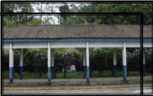
Cubierta Edif. Intendencia Moín
