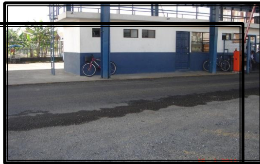
Reparaciones superficie de rodamiento Limón
