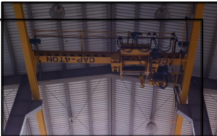
Pintura grúa viajera taller mecánico
