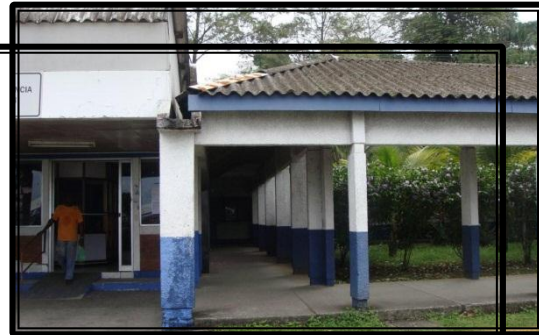
Cubierta Edif. Intendencia Moín
