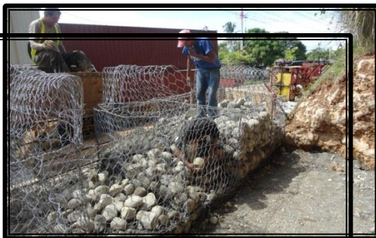
Muro de gaviones
