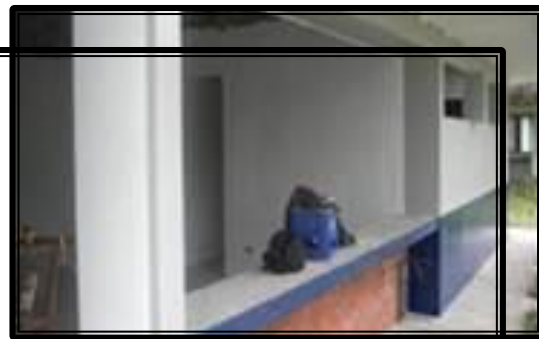
Cobertizo Montacargas Moín
