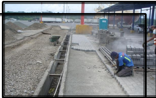
Reparación loza Moín
