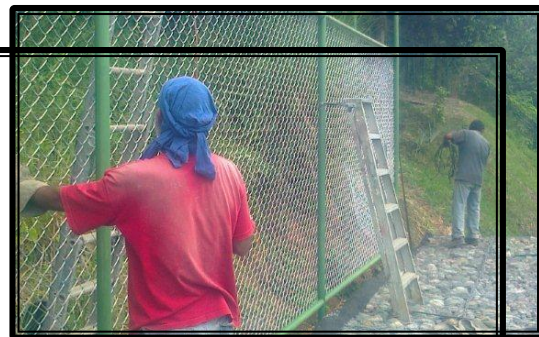
Malla perimetral Moín
