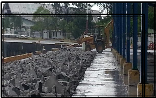
Reparación estructural muelle Moín
