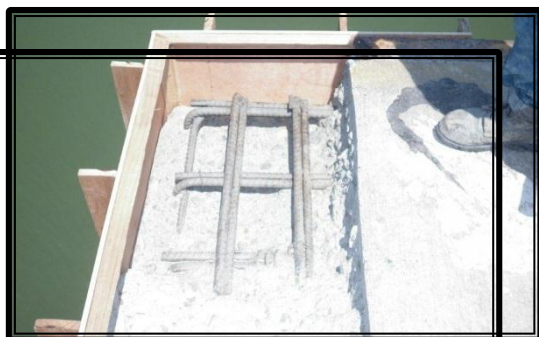
Reparación estructural muelle cruceros
