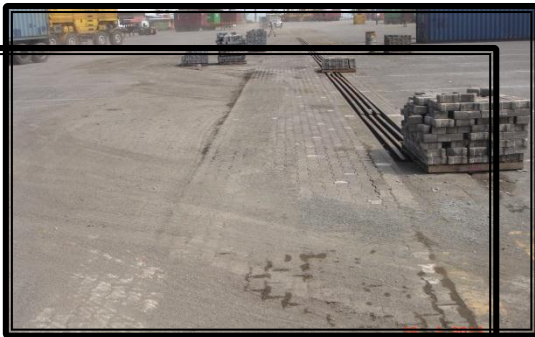
Reparaciones superficie de rodamiento Limón
