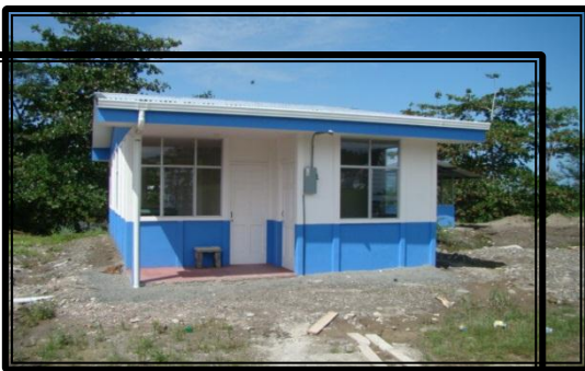
Construcción Unidad K9
