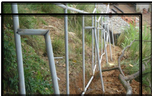
Malla perimetral Moín
