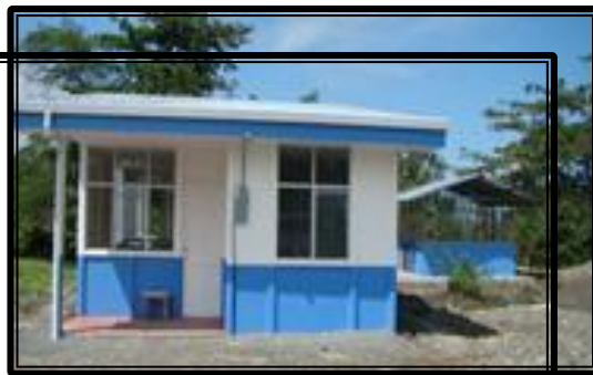
Construcción Unidad K9
