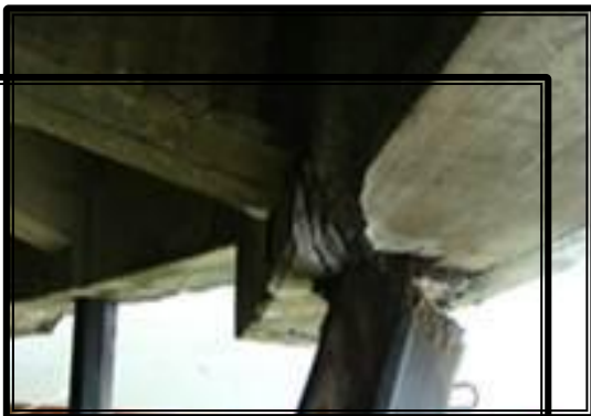
Reparación estructural Muelle Moín
