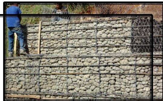
Muro de gaviones
