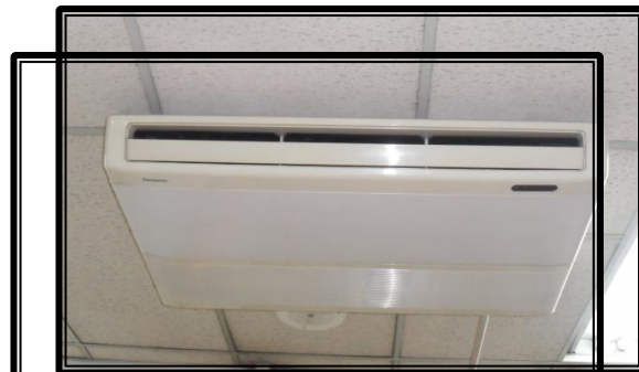
Suministro aires acondicionados
