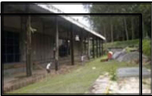
Cobertizo Montacargas Moín
