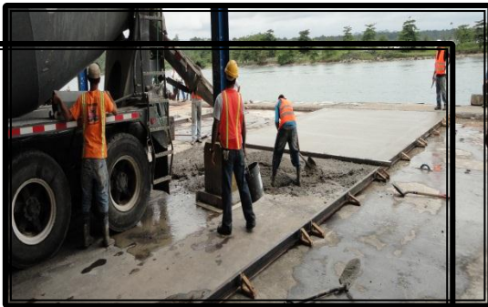
Reparaciones loza Moín
