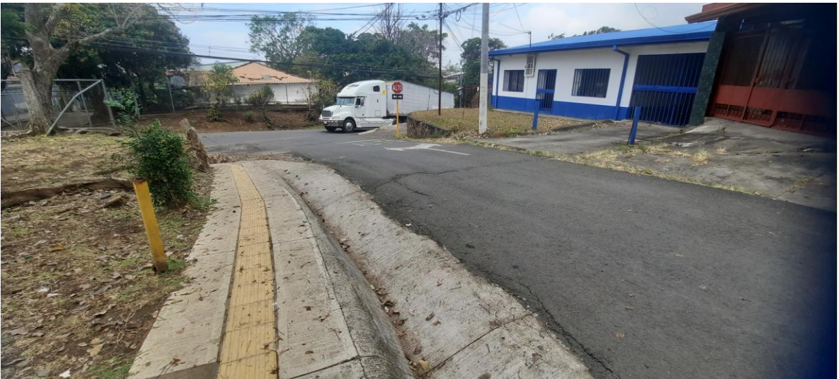
Figura 3 Aceras de calle Tkche con calle San Martín (vista oeste). Fuente propia.
