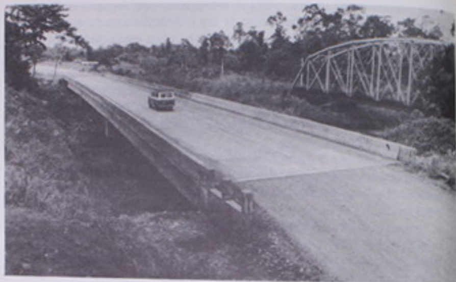
EL PUENTE CONSTRUIDO SOBRE EL RIO PARISMINA SIGNIFICA OTRA DE LAS GRANDES ESTRUCTURAS EN LA NUEVA CARRETERA QUE COMUNICA A SIQUIRRES CON GUACIMO Y GUAPILES.
