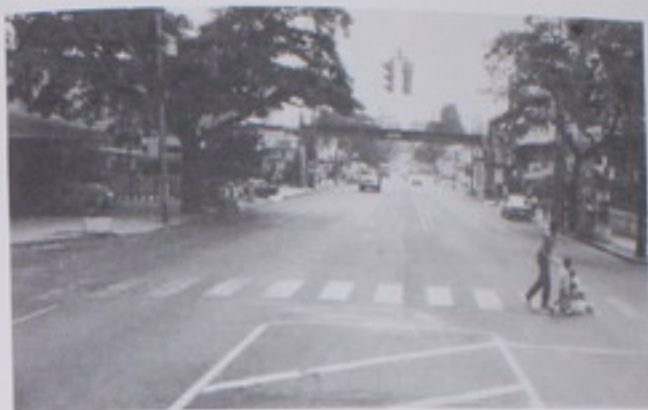
Ingeniería de Tránsito realiza el señalamiento vial en el área metropolitana. En la gráfica un sector del Paseo Colón.
