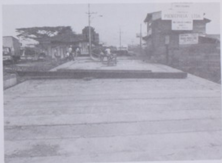
Trabajadores en plena actividad en el puente de Cinco Esquinas.
