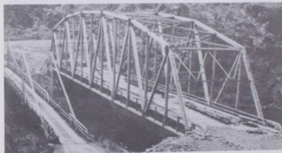
El puente sobre el río Javillos se inauguró recientemente, en una gira del Ministro de Obras Públicas y Transportes a la zona de San Carlos.
