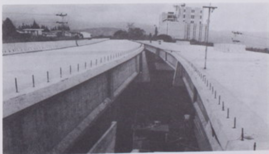
Puente elevado de San Pedro
