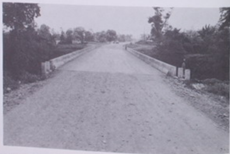
PUENTE DOS NOVILLOS Y PARTE DE LA CARRETERA EN CONSTRUCCION SIQUIRRES-GUACIMO-GUAPILES.
