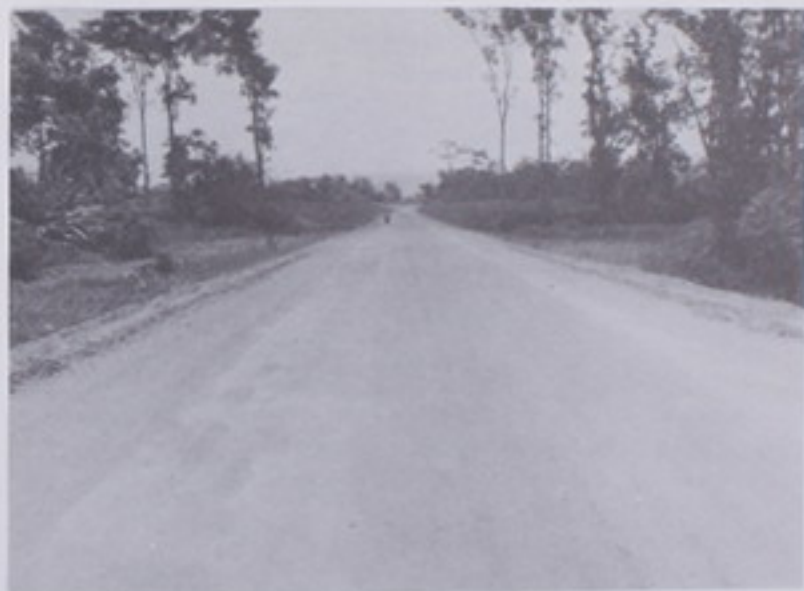
VISTA PANORAMICA DE LA NUEVA CARRETERA ACTUALMENTE EN CONSTRUCCION ENTRE SAN JOSE-SIQUIRRRES-PUERTO VIEJO
