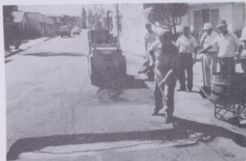
Trabajadores en labor de bacheo.
