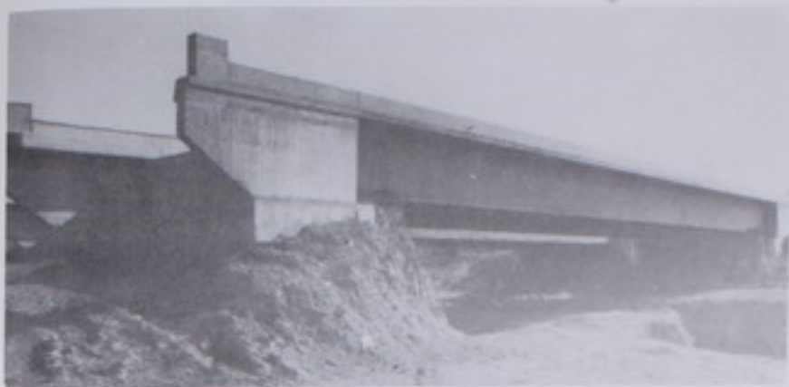
El puente de Taras forma parte del proyecto Tres Ríos Cartago.
