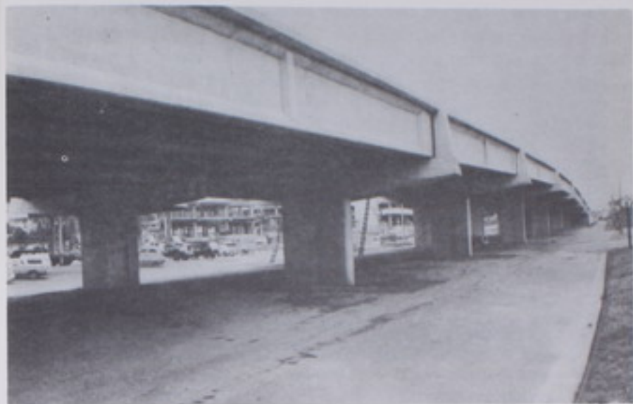
Puente elevado frente al Hospital México
