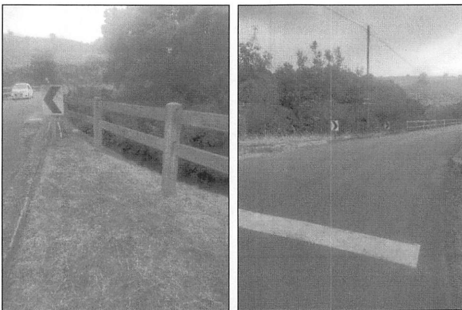
Imágenes 9 y 10. Vista de acceso oeste del puente.
