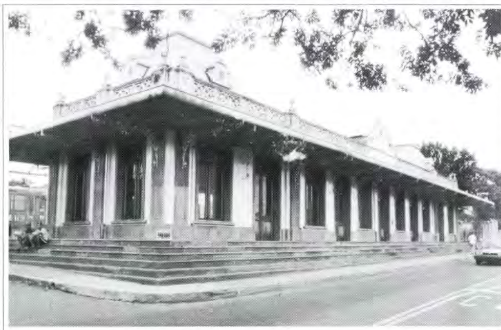
La antigua estación al Atlántico, hoy restaurada, abriga al nuevo Museo del Ferrocarril.
