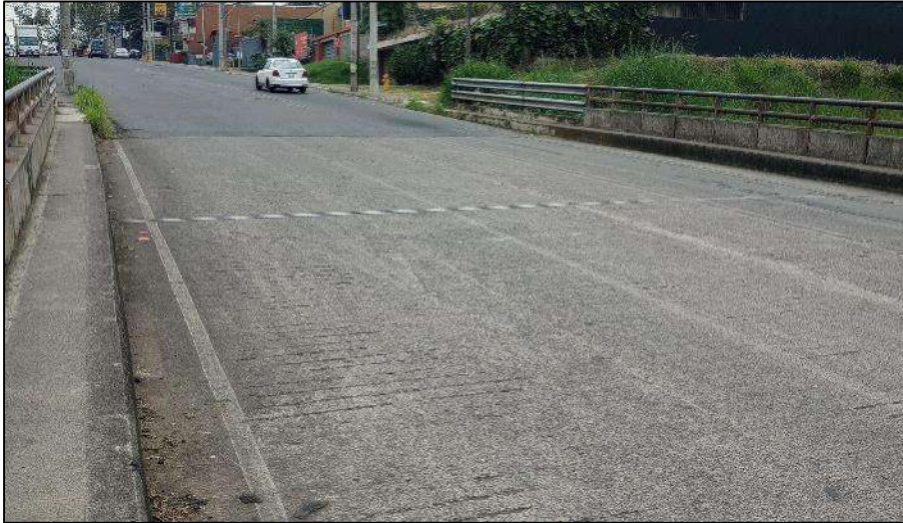
Imagen 8 vista acceso este del señalamiento horizontal.
