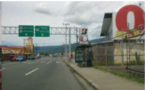
Frente Iglesia, sentido barrios
