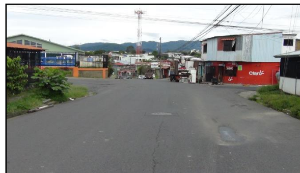
Figura.3 condiciones de visibilidad y estado del señalamiento vial, Ruta de Travesía N°10119, Colonia 15 de Septiembre.
