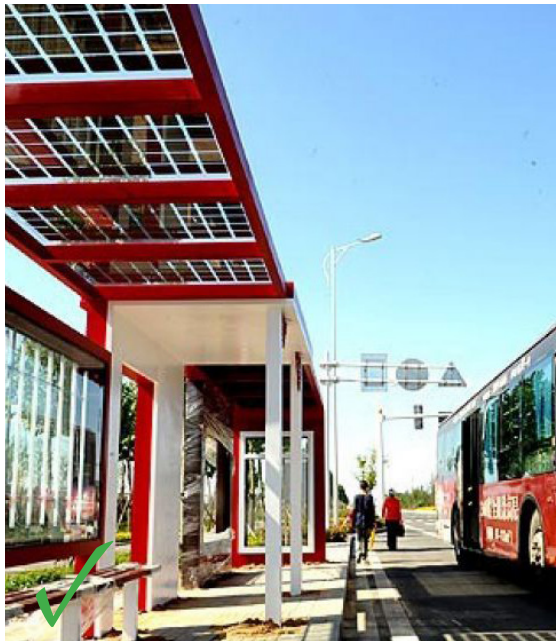
Ejemplo de instalación de paneles solares para ayudar a la autonomía energética de las paradas de autobús.
