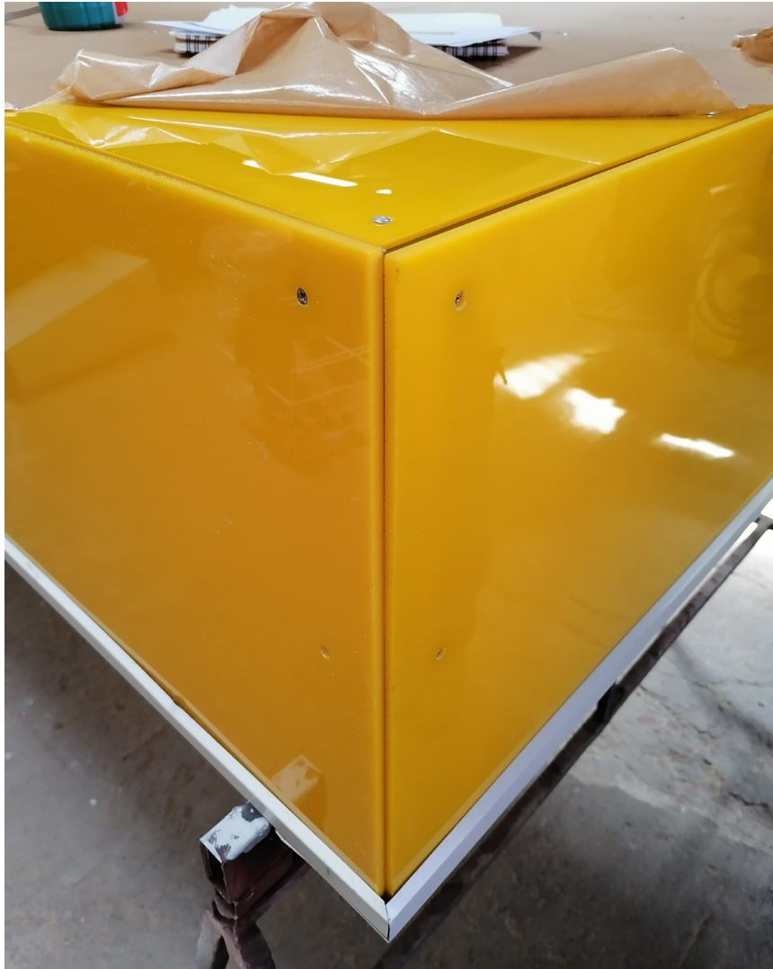
Detalle de cerramiento de acrílico en el prototipo de cubiertas. Fotografía de autoría propia.
