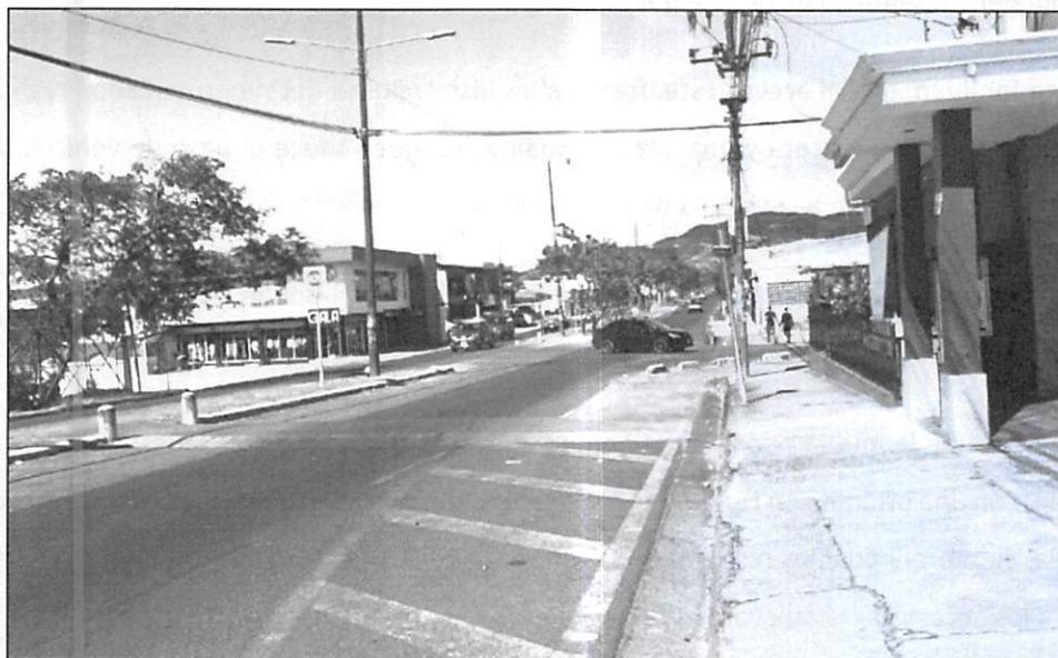
Figura 2 Acceso Este Boulevard El Molino, se aprecia reductor de velocidad tipo acera, estado de la demarcación de horizontal de la calzada, vista de Este-Oeste.
