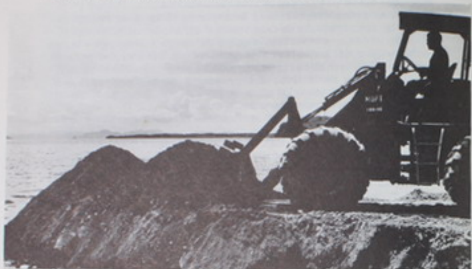
Atracadero de Manzanillo.
