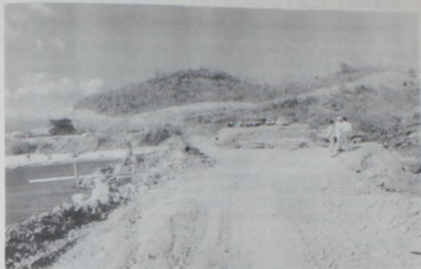
Instalación del muelle en Punta Morales
