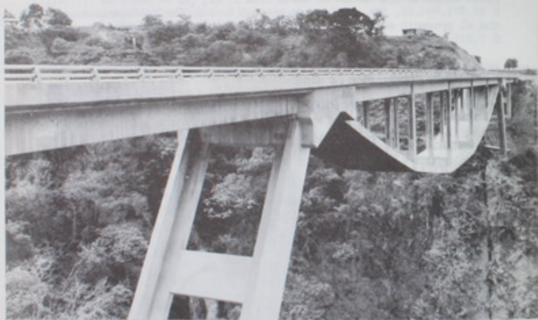
Puente sobre el Río Colorado
