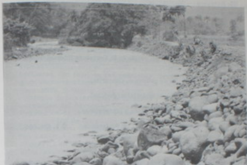
Levantamiento de diques en la Suiza (Turrialba).
