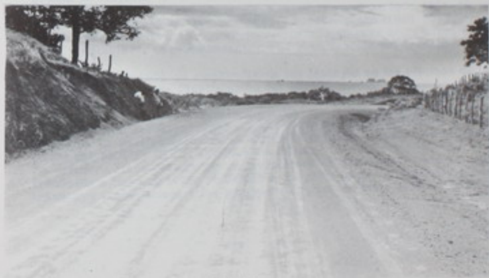
Proyecto Villarreal - Huacas - Brasillito
