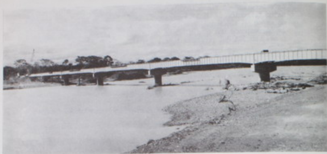
Puente sobre el Río Chirripó de 432 metros de largo, en la carretera entre Limón y Siquirres.
