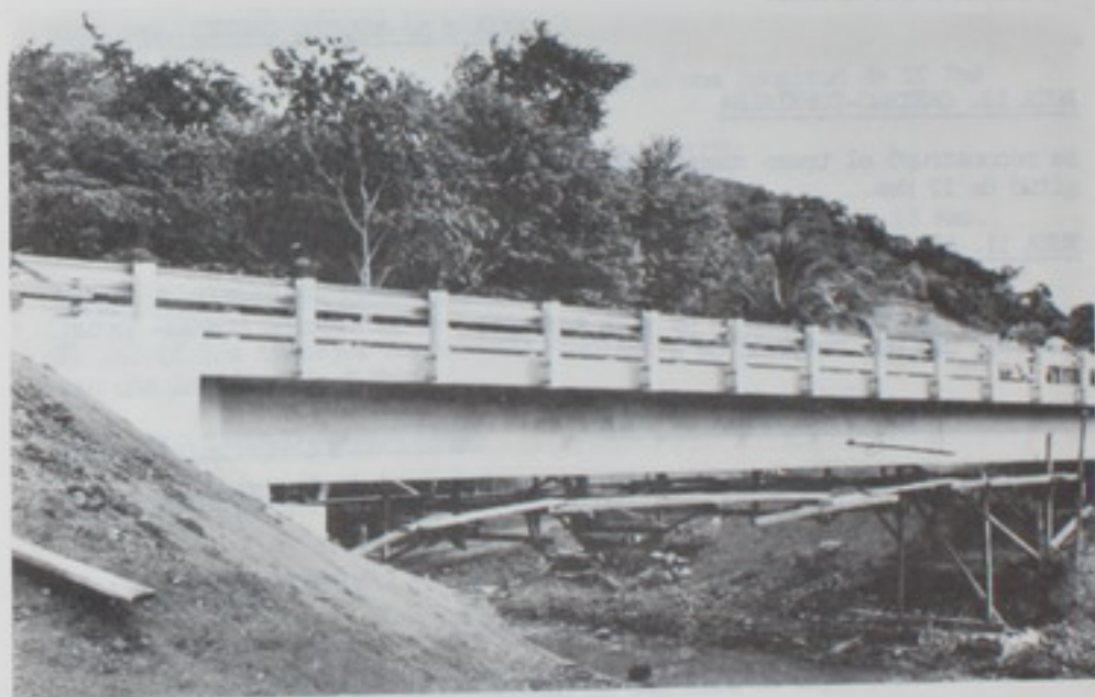
Puente sobre el Río San Andrés. Proyecto Huacas - Villareal
