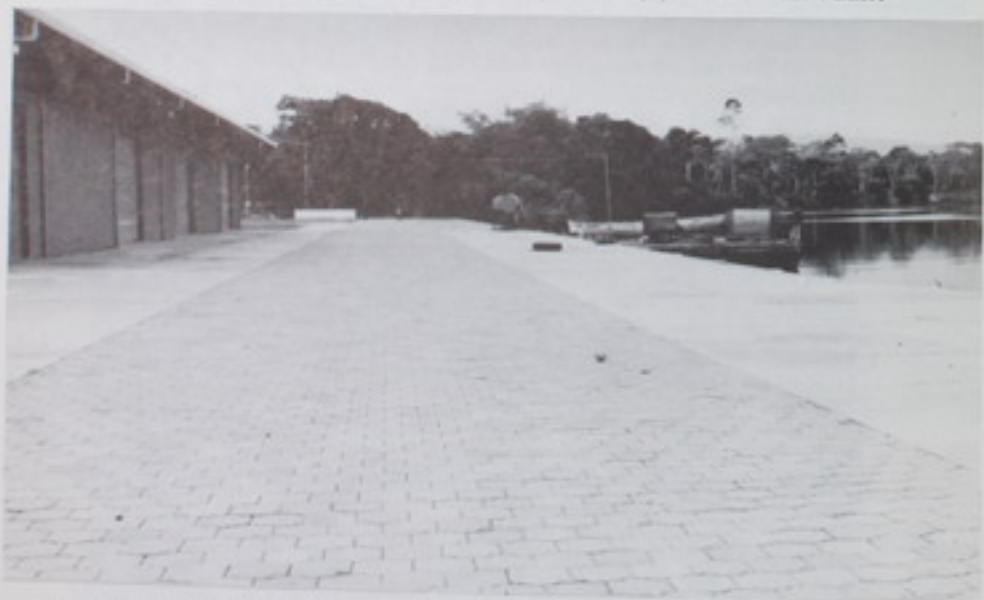
La terminal para barcazas en Moín tiene 120 metros de atracaderos, una amplia plataforma de carga y descarga, bodegas, taller y oficinas administrativas.
