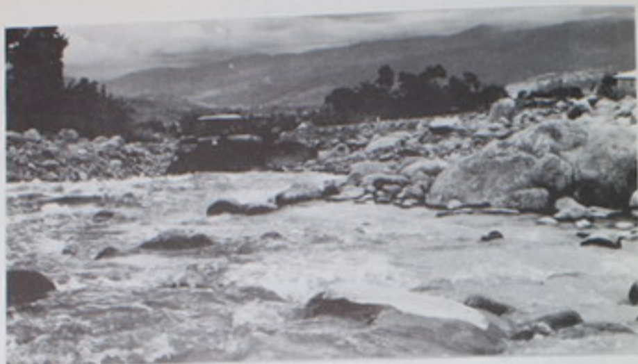
Construcción de diques en Turrialba.
