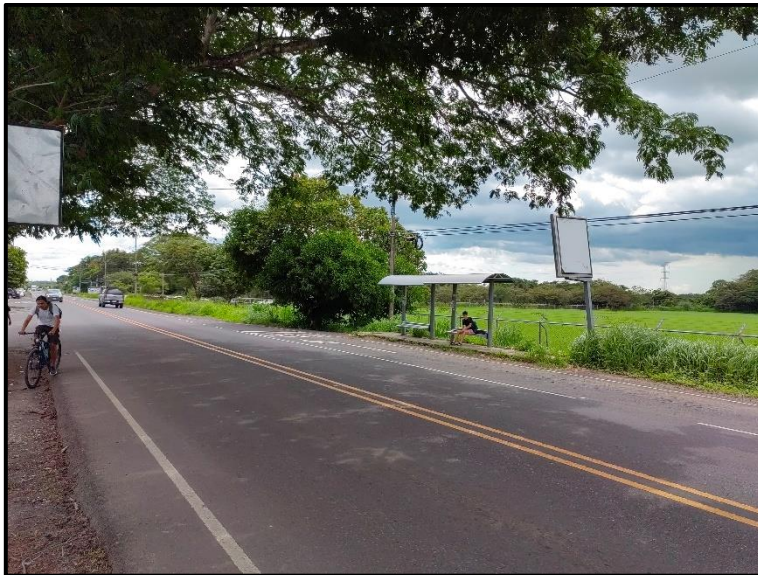
Imagen N° 2. Carpeta Asfáltica Ruta Nacional N° 21.
