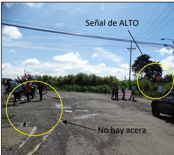
Figura N° 4 Señalamiento vial existente, tramo sin acera.
