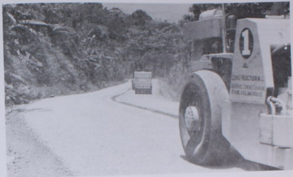
ASFALTADO DE LA CARRETERA ENTRE PAVONES Y SIQUIRRES
