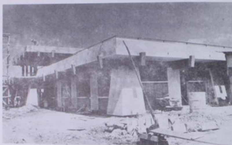
EDIFICIO TERMINAL AEROPUERTO DE PAVAS
