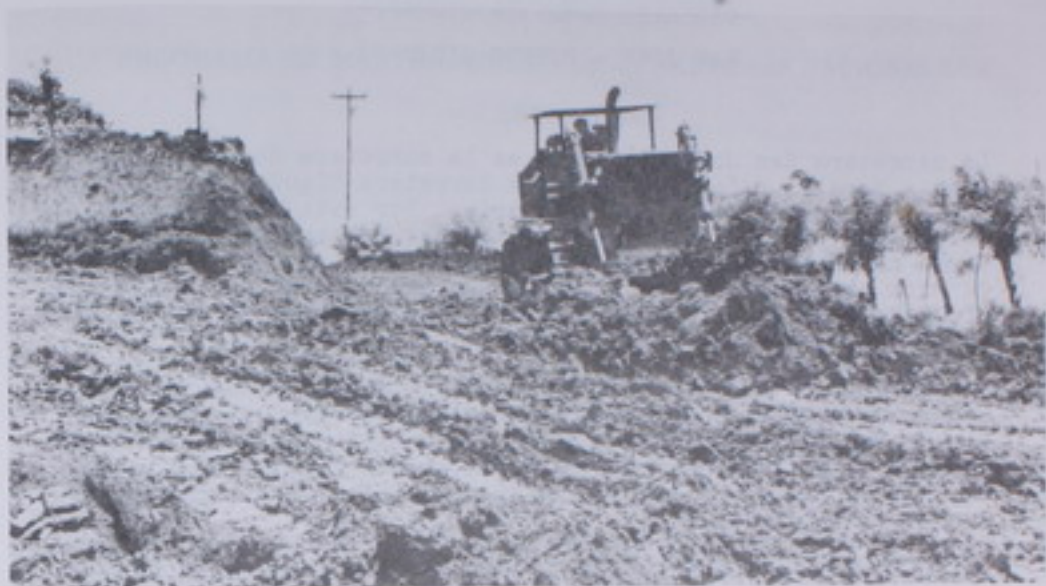
CARRETERA A PUERTO VIEJO (MANTENIMIENTO)
