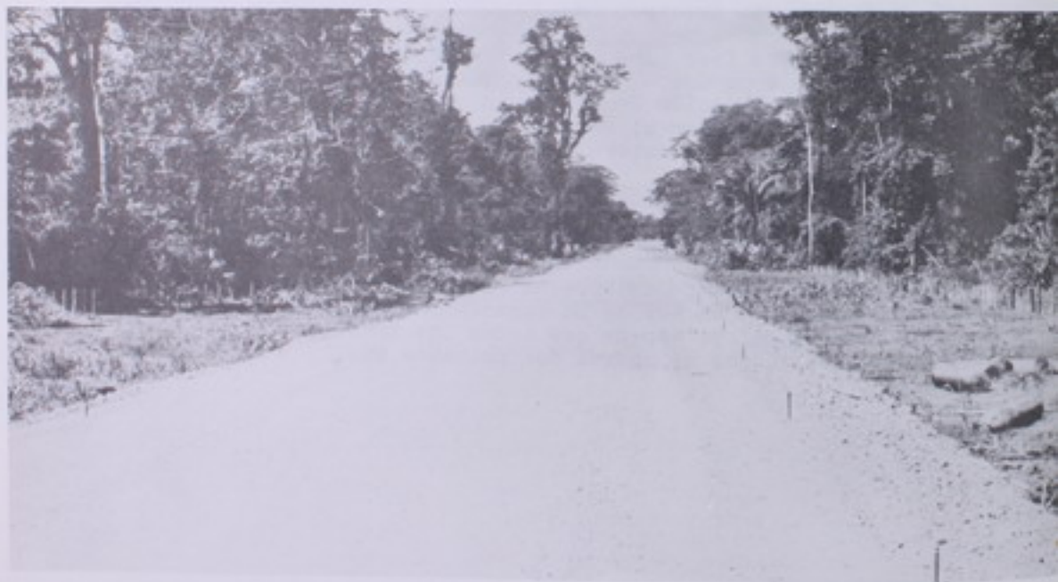
Panorámica de la Carretera en construcción entre Limón y Siquirres
