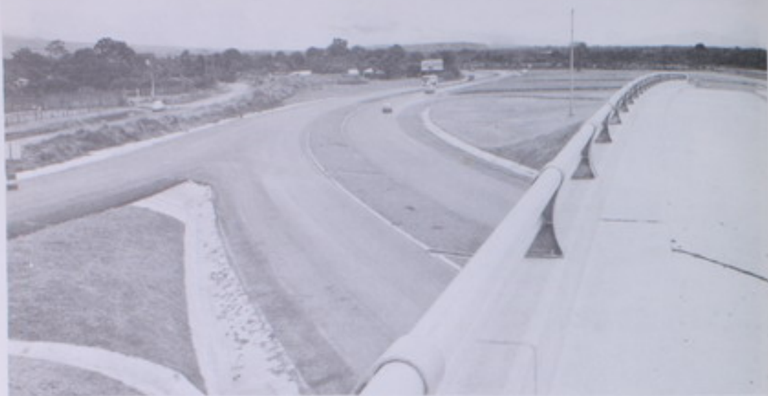
CARRETERA EL COCO-SAN RAMON . SE OBSERVA PARTE DE UN PASO SUPERIOR
