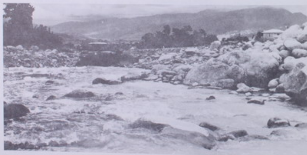
CONSTRUCCION DE DIQUES EN TURRIALBA
