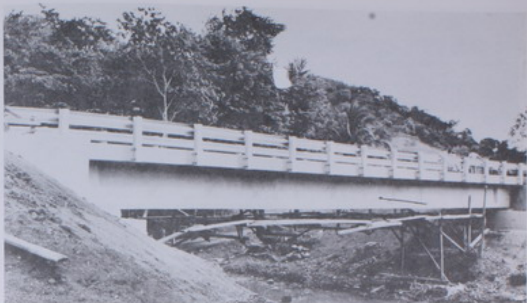
PUENTE SOBRE EL RIO SAN ANDRES. PROYECTO HUACAS-VILLAREAL
