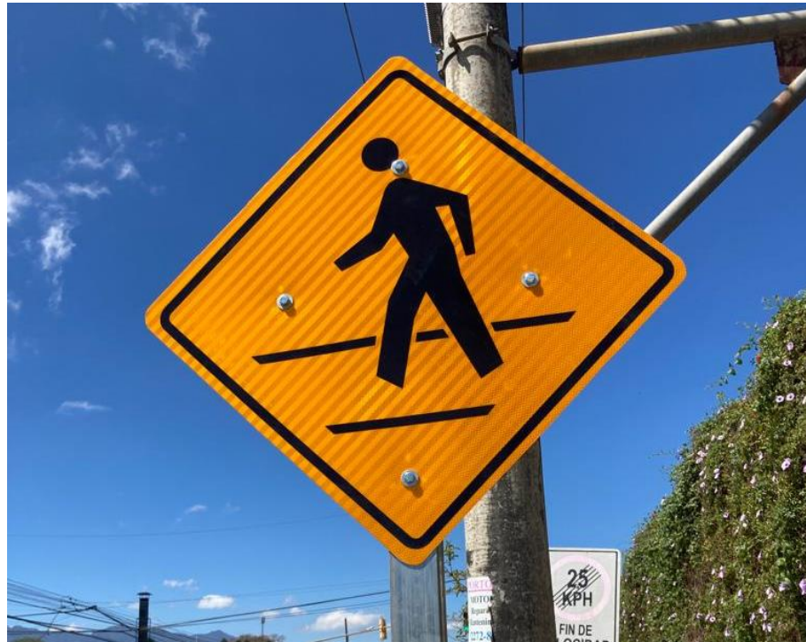
Figura 7. Señal vertical colocada. Fuente: Propia, 2022.
