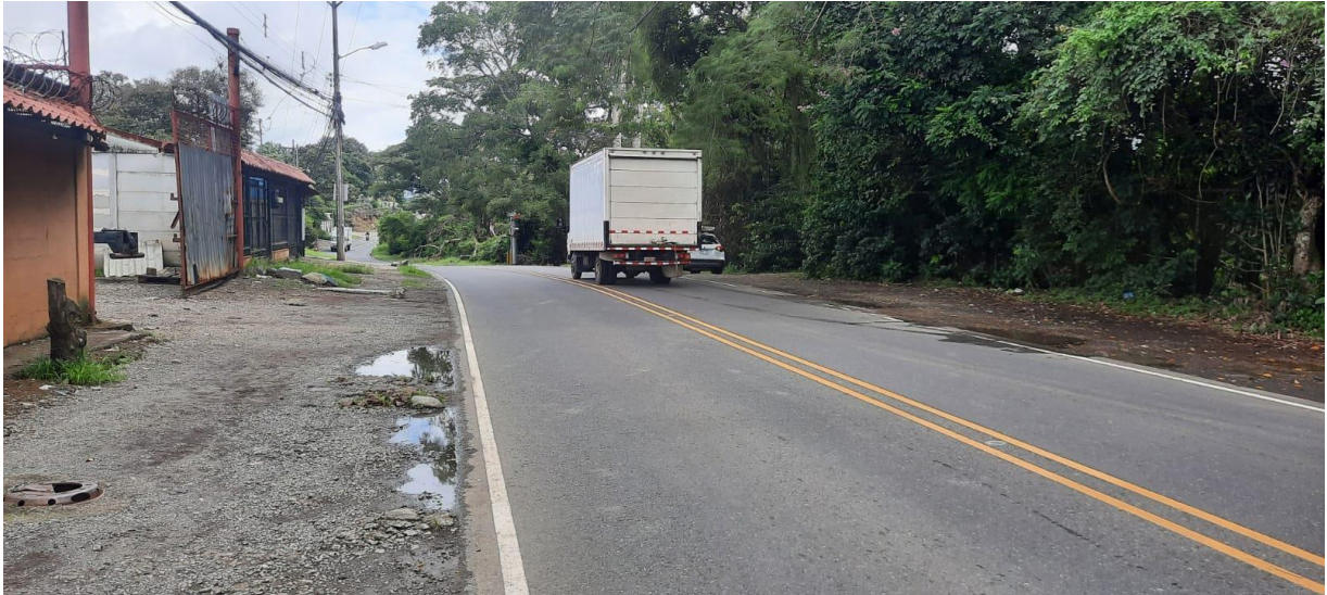
Figura 3 Vista hacia el este de intersección con Ruta Nacional N.° 124 con calle Las Ciruelas San Antonio, Alajuela. Fuente: Propia.
