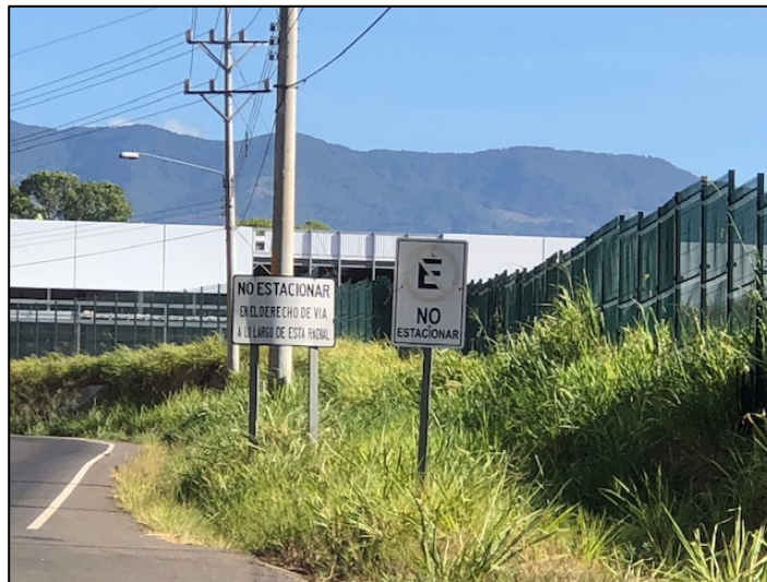
Figura 4. Señalamiento vertical con plantillas borrosas.
