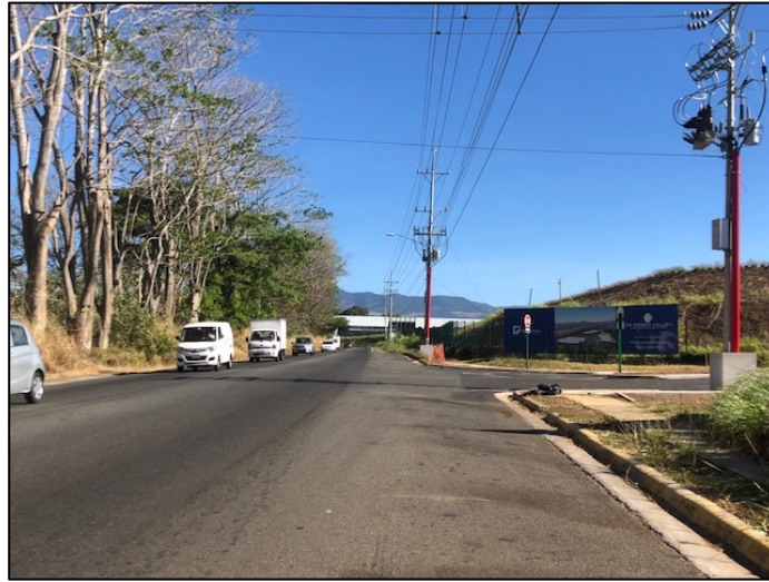
Figura 3. Señalamiento horizontal inexistente frente al acceso.
