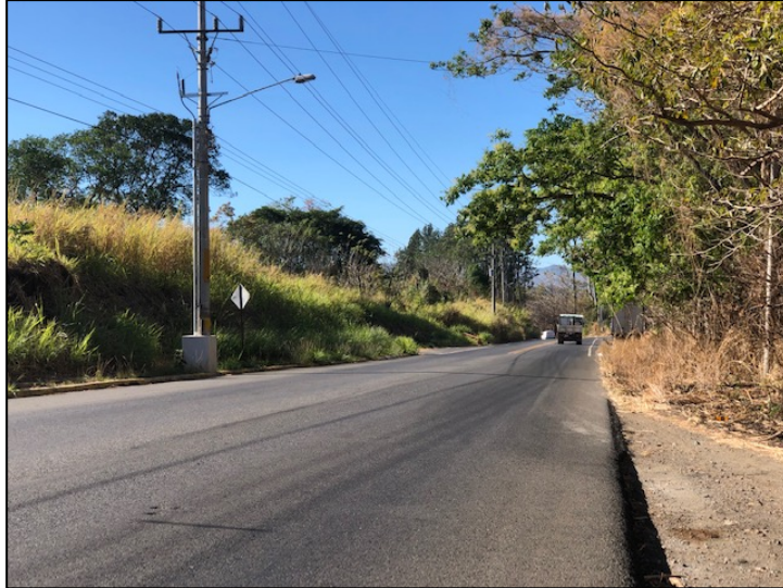
Figura 5. Espaldón en asfalto y seguido de lastre
