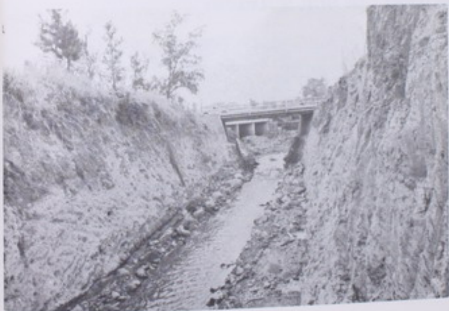
CANALIZACION DEL RIO MARIA AGUILAR
