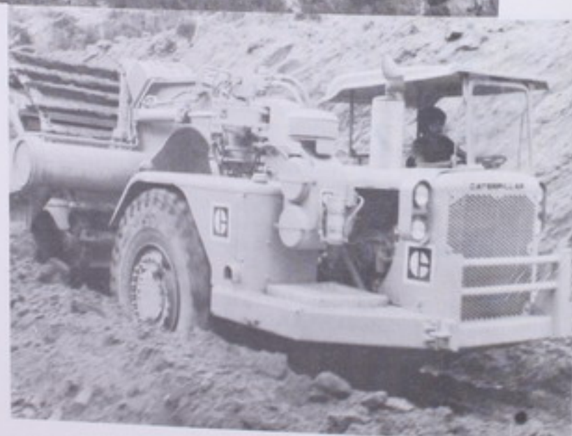
MAQUINARIA TRABAJANDO EN CAMINOS VECINALES
