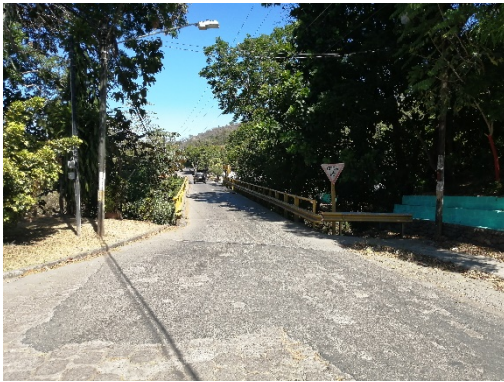
Figura N° 4. Puentes angostos entrada a la zona del CTP
