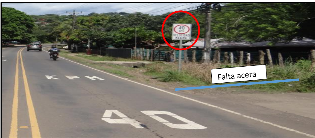
Imagen N° 3. Falta de acera y señalamiento vertical en buen estado.
