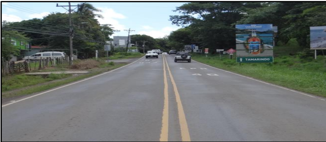
Imagen N° 2. Carpeta asfáltica Ruta Nacional N° 152.
