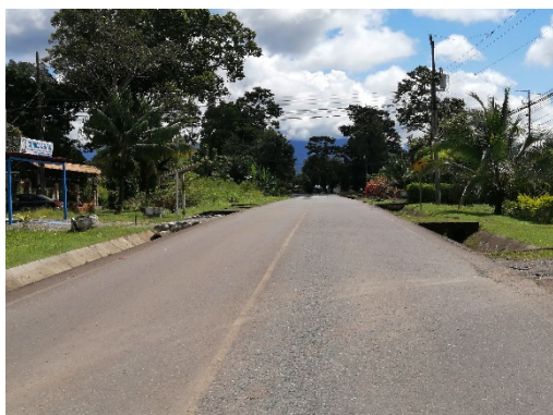
Figura N° 2. Ruta Nacional N° 616, sentido 1-2 La Managua- Naranjito
