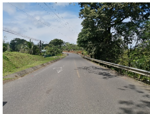
Figura N° 3. Ruta Nacional N° 616, sentido 2-1, Naranjito – La Managua
