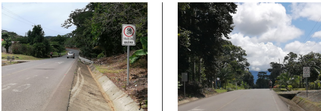
Figura N° 4. Señalamiento vial vertical y horizontal en la zona
