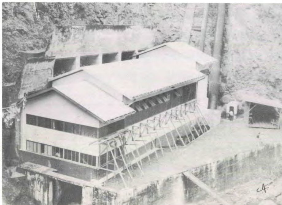
CASA DE MAQUINAS DE LA PLANTA ELECTRICA DE TACARES
