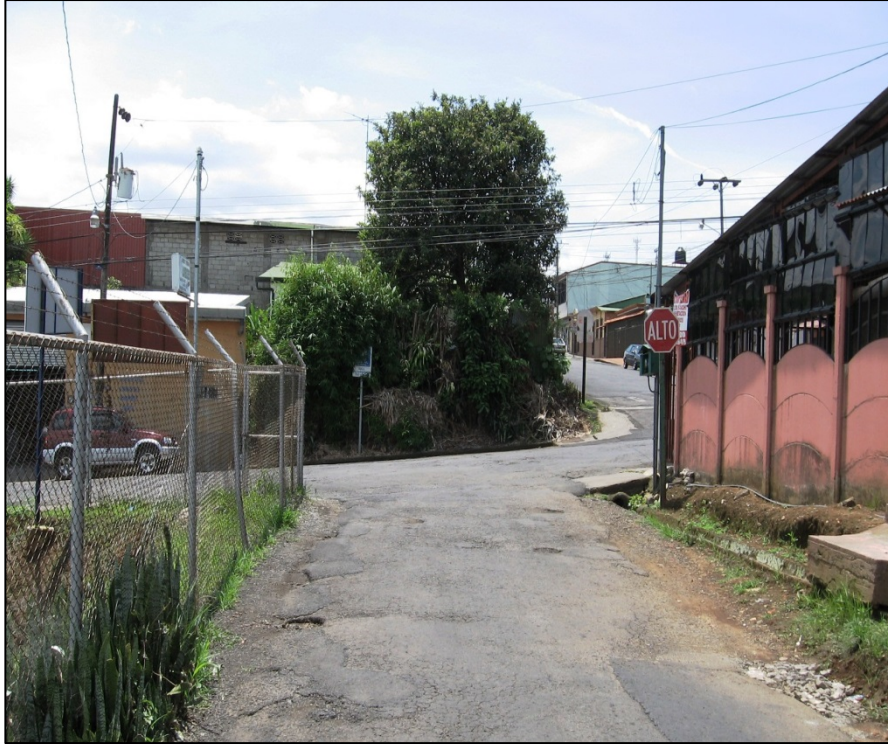
Figura N°4. Señalización vertical existente sobre avenida 3, horizontal inexistente
