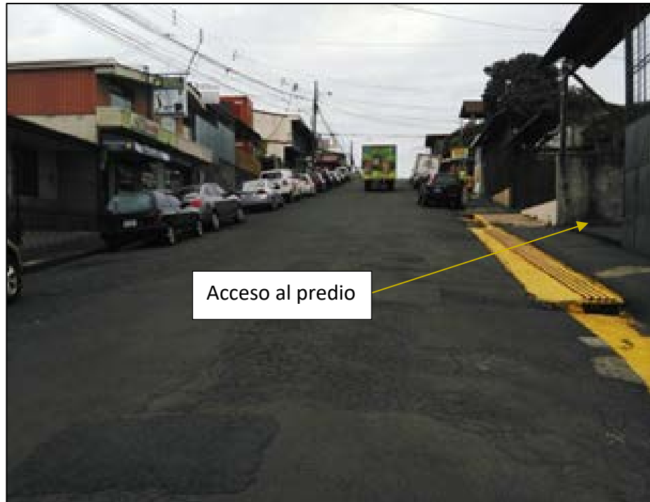
Figura N°2. Señalamiento horizontal cordón amarillo, carpeta con baches, cunetas y acera
