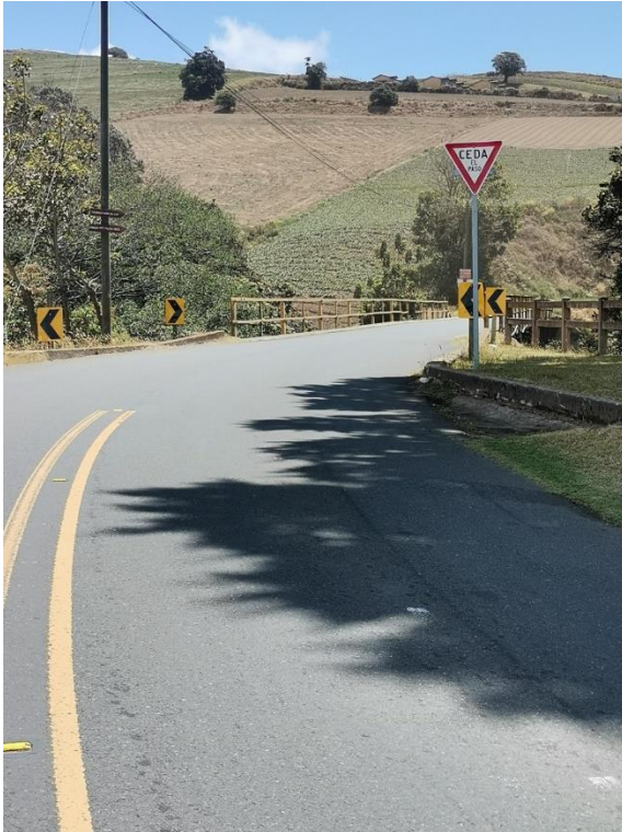
Imagen 4. Condición de demarcación. Fuente: Propia, 2022.
