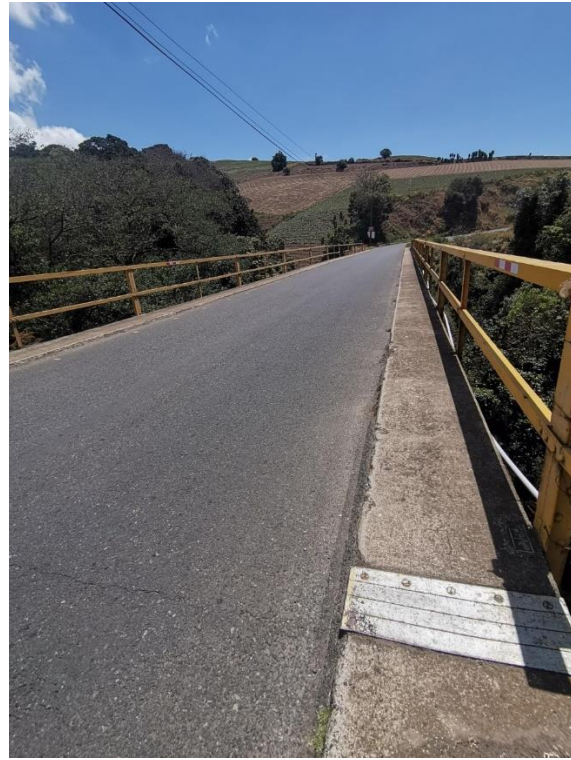
Imagen 5. Condición de demarcación. Fuente: Propia, 2022.
